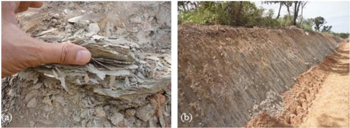
Figura 4.25 – Folhelhos de filito encontrado durante os trabalhos de regularização da área (a) e o reforço de subleito compactado sobre o solo regularizado(b).
