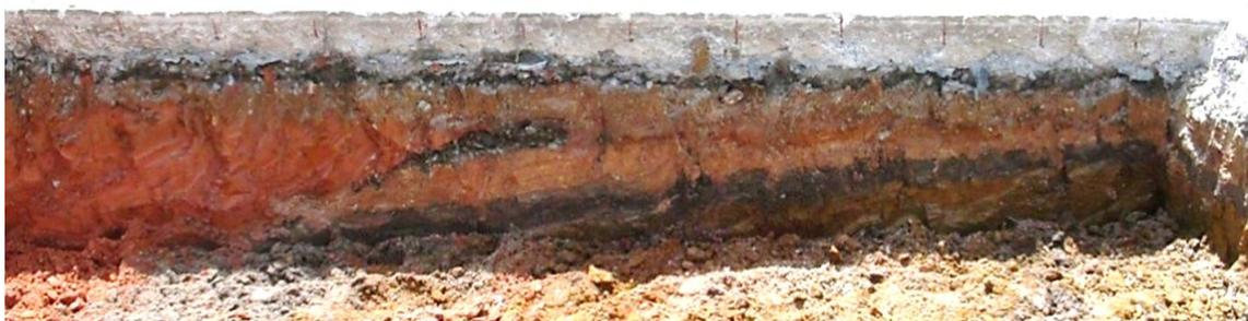
Figura 4.44 – O registro fotográfico é da trincheira aberta para fins de calibração da velocidade de propagação da onda eletromagnética no pavimento rígido da BR101.
