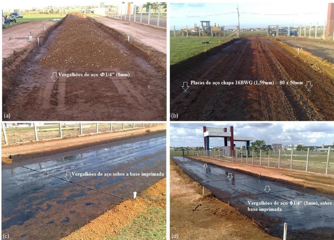
Figura 4.11 - Fotos ilustram a implantação de vergalhões e placas de aço no pavimento de Campo Verde. (a) vergalhões sobre o subleito; (b) placas de aço sobre o subleito; (c) e (d) vergalhões sobre a camada de base imprimada.
