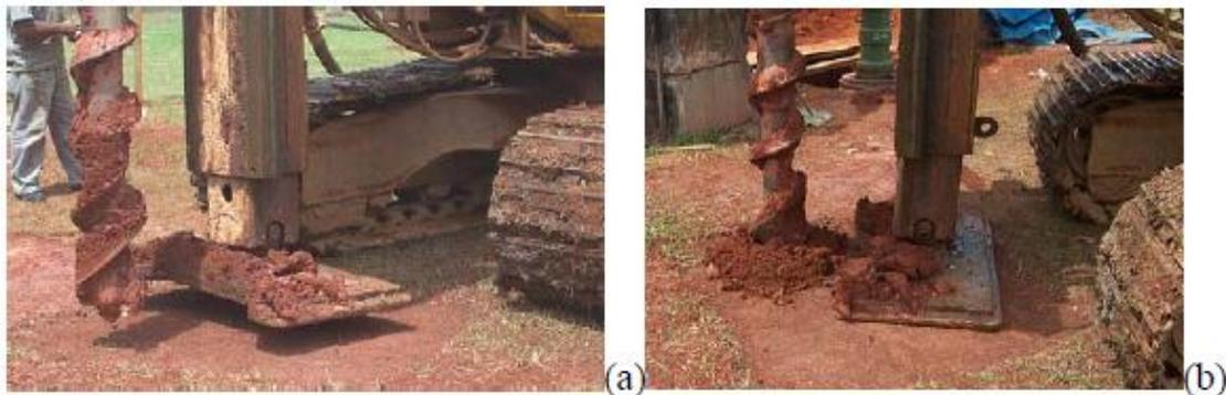
Figura 3. 6 – Execução de estacas hélice contínua no C.E.UnB.
