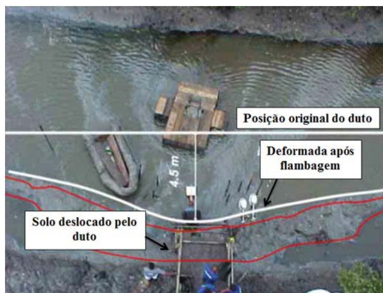
Figura 2.7 Deformada do solo empurrado pelo duto PE-II após o acidente de janeiro de 2000 na Baía de Guanabara. (Cardoso, 2005).
