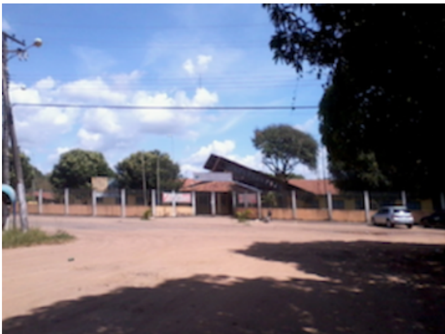
Figura 13: Entrada da SR(27)
