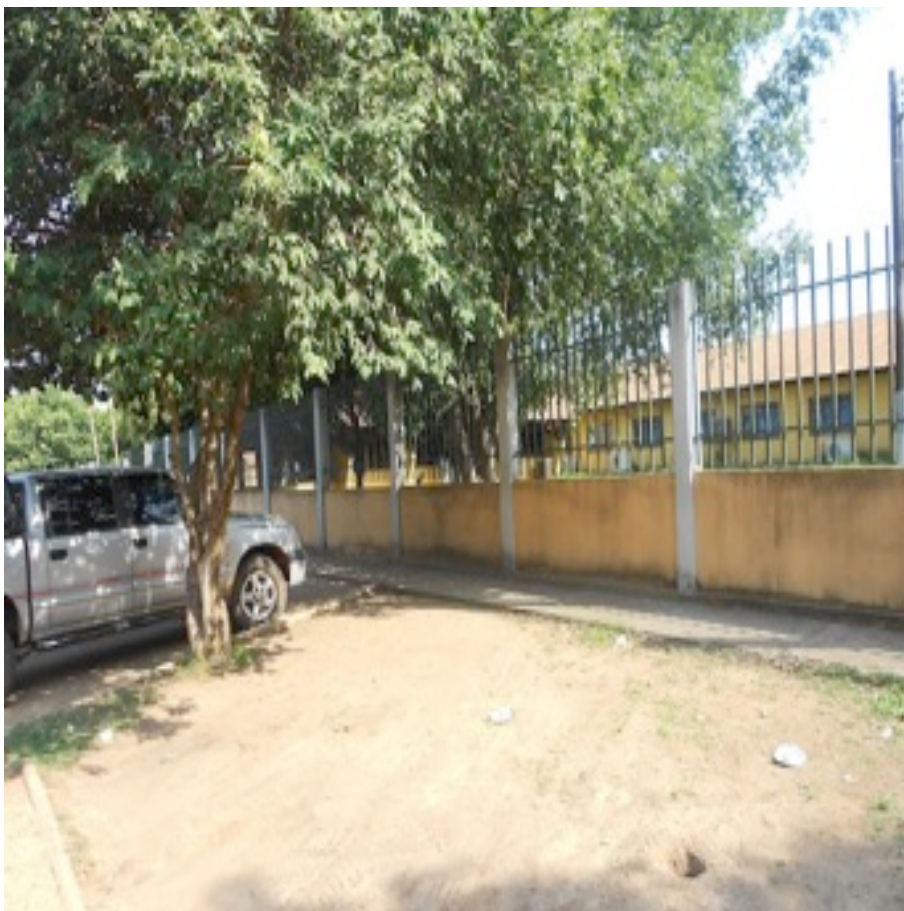
Figura 15: Muro externo da SR(27)
