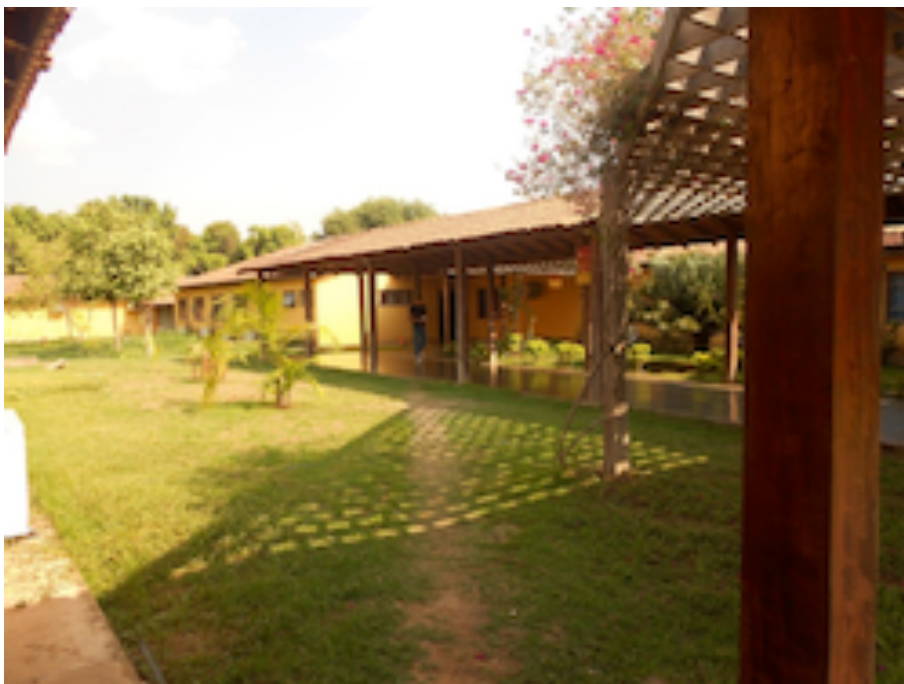
Figura 17: Corredor no interior da SR (27)
