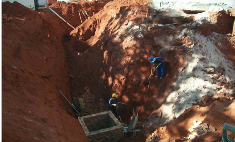
Figura 1.1 – Vala em solo lateríticos onde ocorreu acidente que vitimou três operários (Dias, W/ Abr - Agencia Brasil, 21.07.2011)
