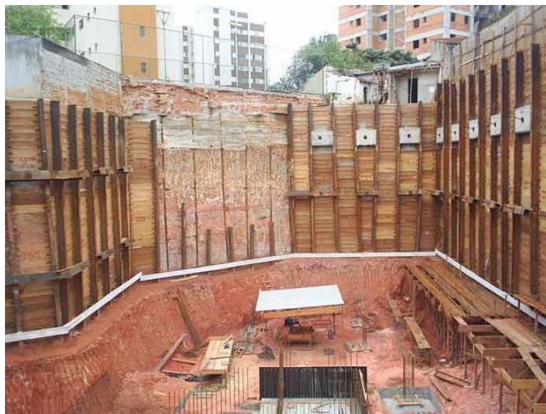
Figura 1.2 - Cortina de estacas cravadas metálicas (Foto cedida pela Infraestrutura Engenharia Ltda., Disponível em: http://www.infraestrutura.eng.br/obra.asp?obra=241 ).
