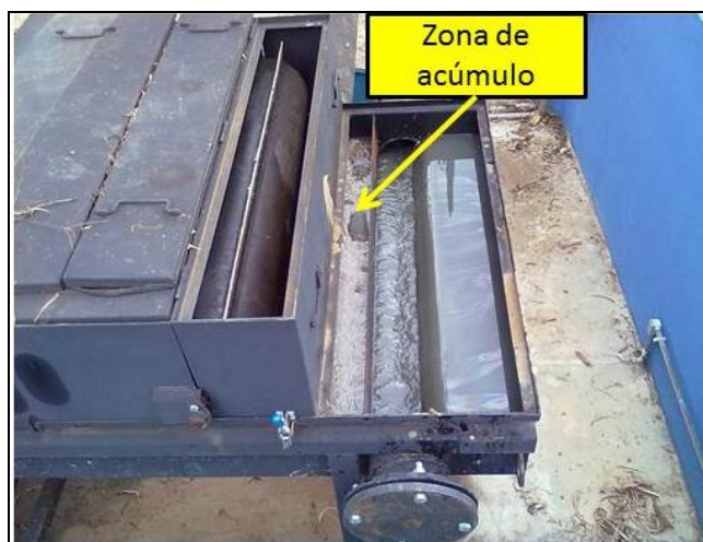
Figura 5.9 - Presença de uma zona de acumulação na Unidade Central.
