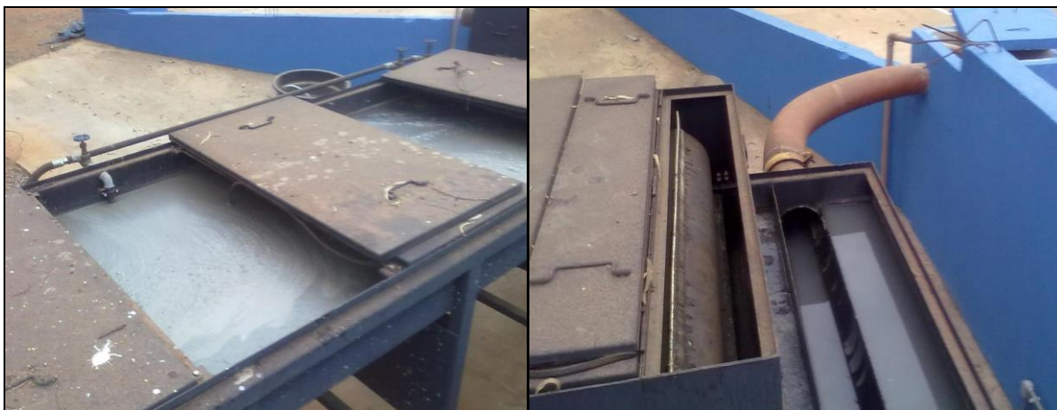
Figura 5.30 - Unidade Central da Estação piloto com resíduos gordurosos e lodos de fossas (à esquerda) e sua saída do efluente que segue para entrada da ETEB Sul (à direita).
