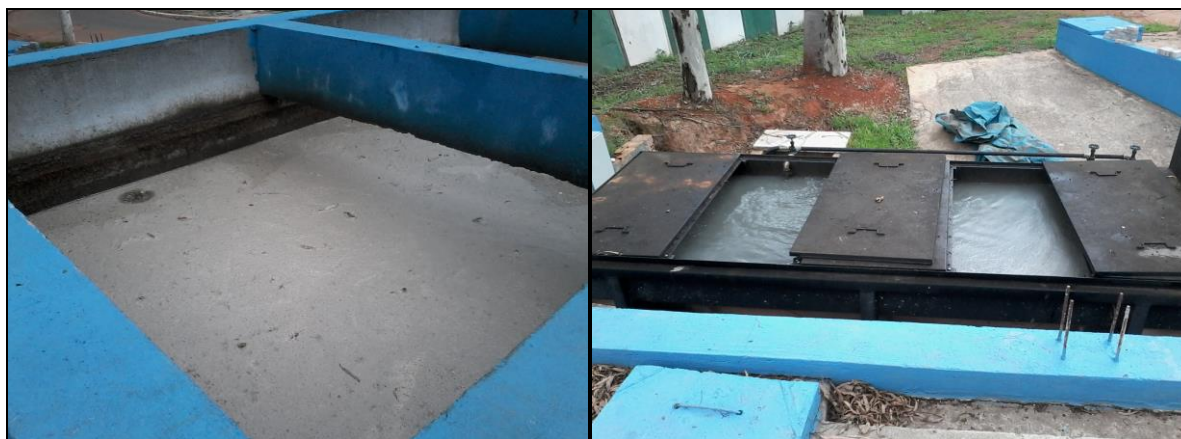
Figura 5.29 - Tanque equalizador com a mistura de resíduos gordurosos e lodo de fossa (à esquerda) e Unidade Central após o tanque equalizador (à direita).
