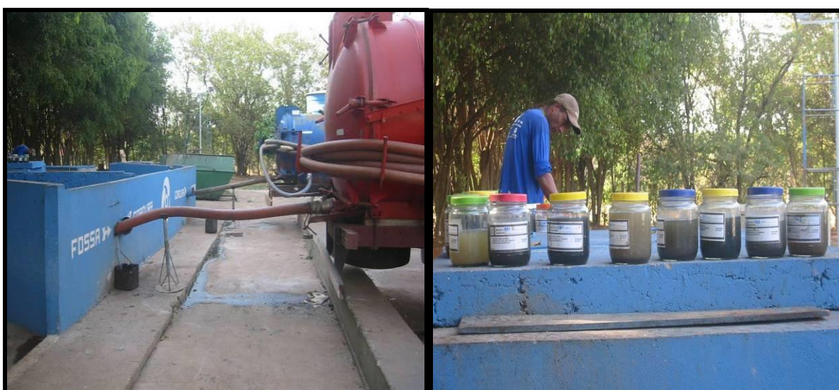
Figura 4.2 - Descarga de caminhões limpa-fossas na estação existente (à esquerda) e amostras coletadas durante o dia (à direita).
