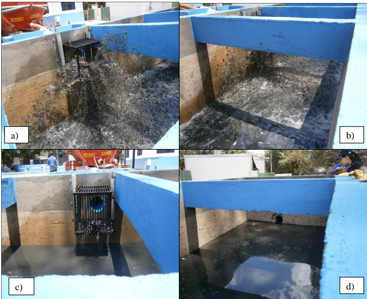
Figura G.2 - a) Momento do descarte de um caminhão limpa fossa no tanque equalizador; b) Homogeneização parcial no tanque equalizador; c) Caixa grade após o descarte; d) Nível do tanque próxima a saída que passa pela peneira.
