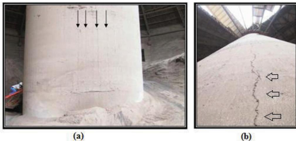
Figura 1.7- Quadro de fissuração em um silo de clínquer. (a) Fissuras circunferenciais. (b) fissuras axiais. (Carmona & Pinto Jr., 2005)
