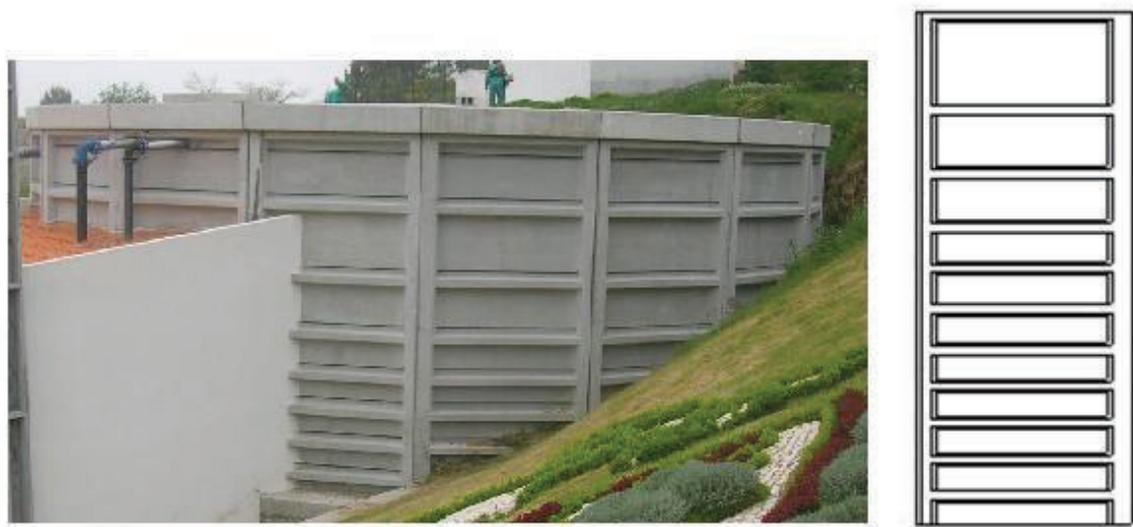
Figura 2.3 – Vista do reservatório pré-fabricado com painéis nervurados, pós-tensionados com cordões auto-embainhados exteriores, e pormenor do painel nervurado (Pereira,2011)
