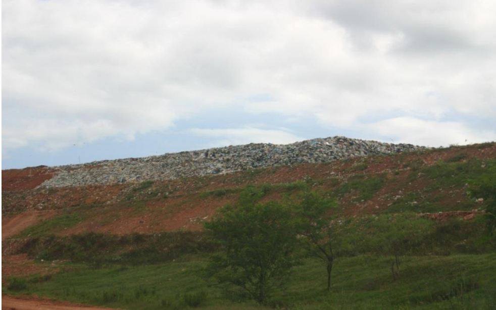
Figura 50 - Aterro sanitário da região metropolitana de Porto Alegre – Dezembro de 2010.
