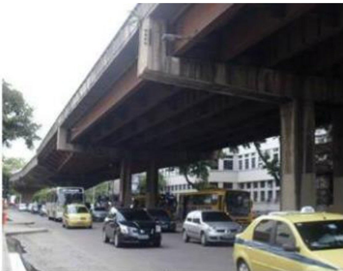
Avenida Rodrigues Alves antes da demolição do elevado Fonte: CDURP
