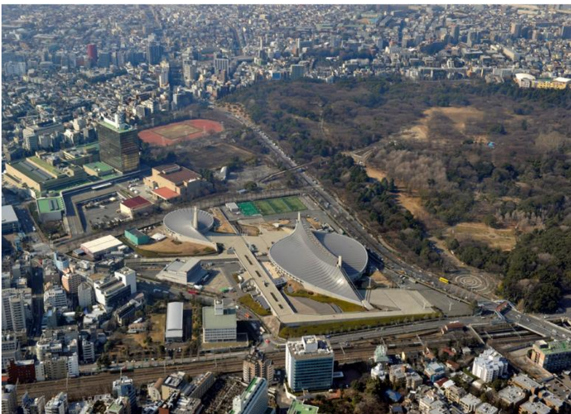
Yoyogi National Gymnasium é famoso pelo design do telhado suspenso que foi projetado por Kenzo Tange. Acima, durante a construção para as Olimpíadas de 1964. Abaixo, foto atual. Fonte: http://jpri.kyodo.co.jp/
