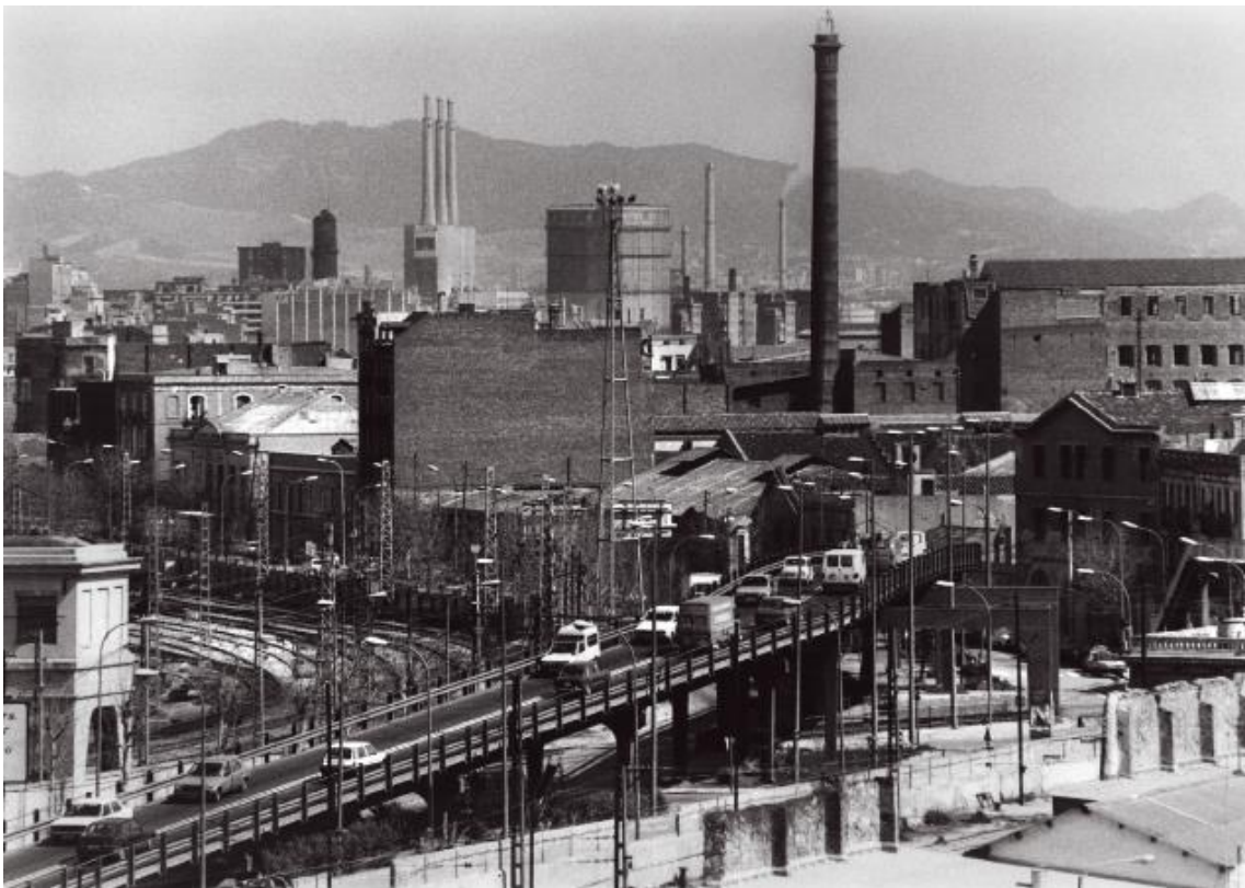
Fábricas Folch, Poblenou (antes da demolição da Vila Icária), 1987 Fonte: http://www.tempusfugitvisual.com/20-Aniversario-JJOO-barcelona92.html
