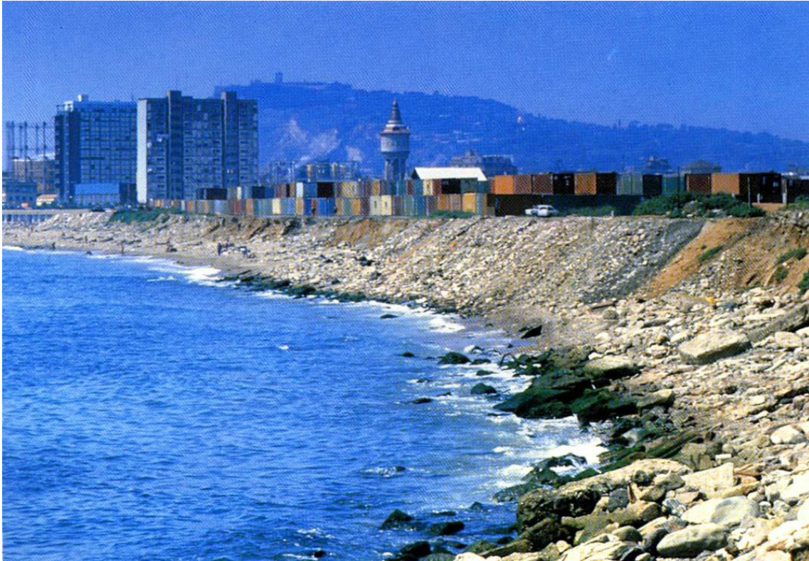
Fachada marítima antes das intervenções
