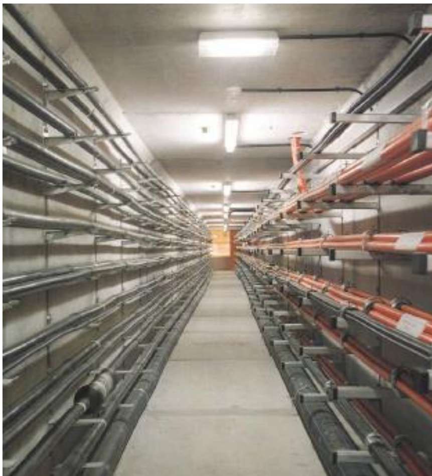
Galeria de serviço subterrânea
