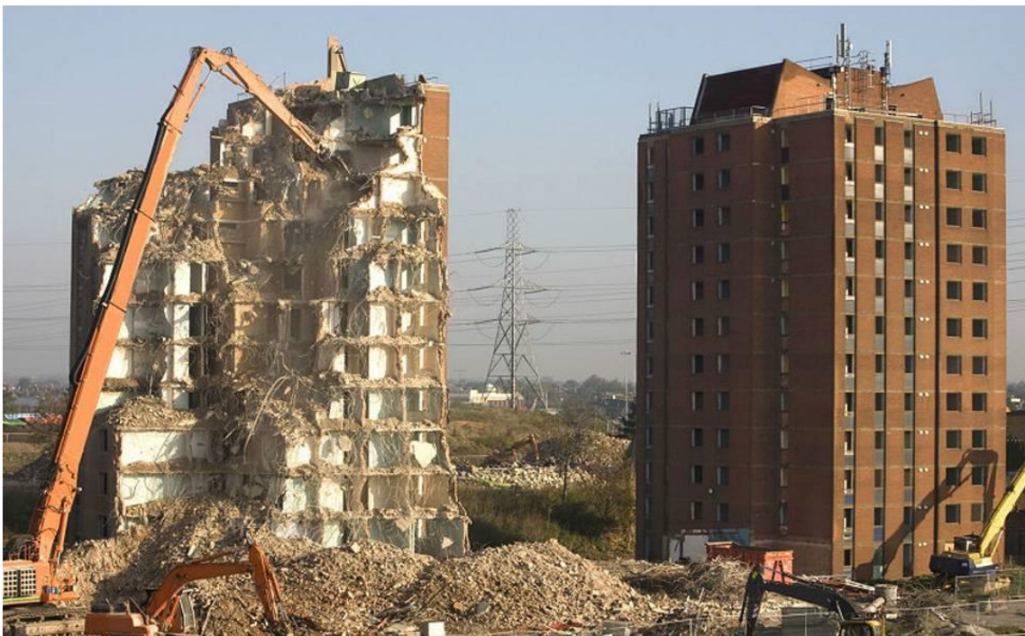
Demolição de alguns edifícios em 2008 Fonte: Arquivo Folha de São Paulo
