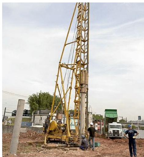
Figura 2.17 Bate estaca para altura crescente de queda – http://www.equipedebra.com.br/construcao-reforma/35/imagens/i267630.jpg
