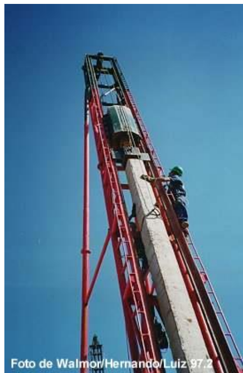
Figura 1.1 Preparação da Estaca Pré-moldada de concreto à ser cravada
