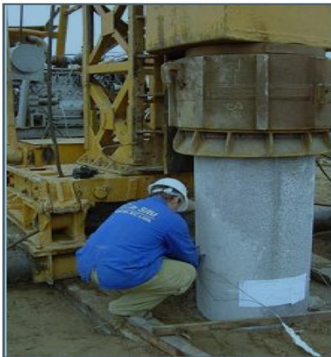
Figura 2.15 Prova de Carga Dinâmica (In Situ Geotecnia S/C)
