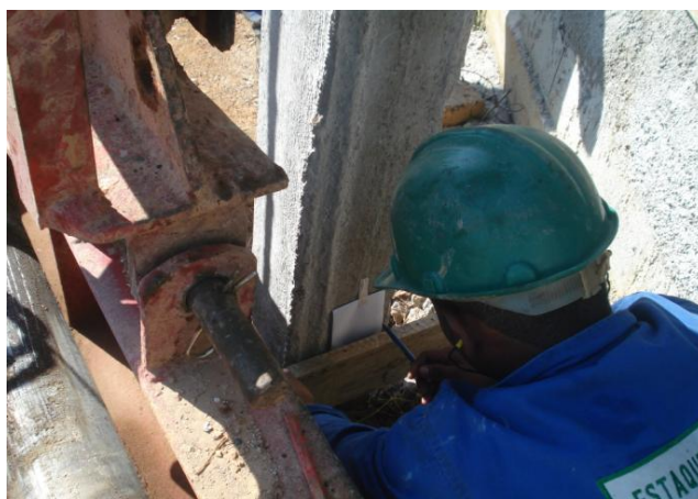
Figura 2.13 Verificação da nega - http://www.geocities.ws/fundacoesufsc20082/f6.JPG
