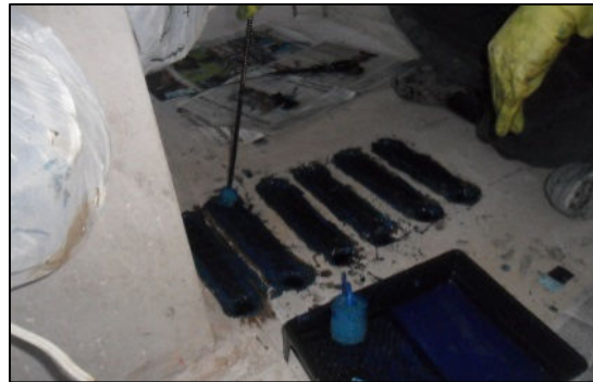
h) Aplicação interna de saturant
