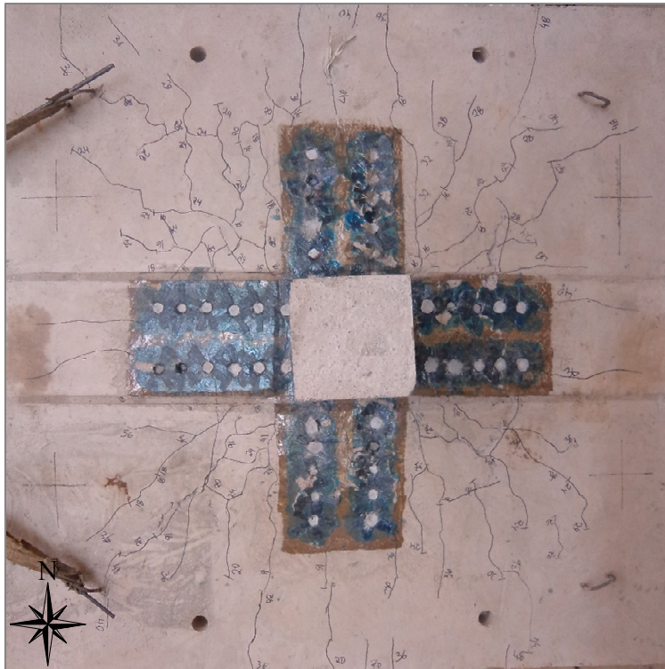
Figura 4.58 – Mapa de fissuração da laje LC-D
