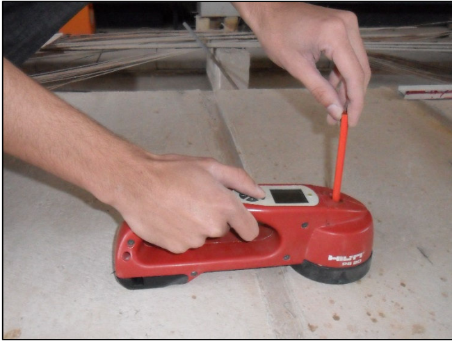
a) Marcação da posição das armaduras
