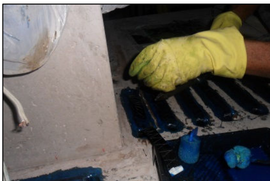
e) Fixação fibras no saturant
