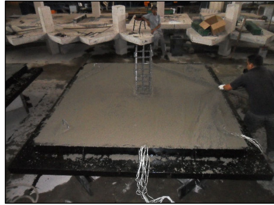
d) Acabamento da concretagem
