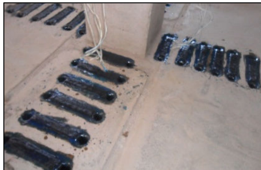
i) Laje reforçada
