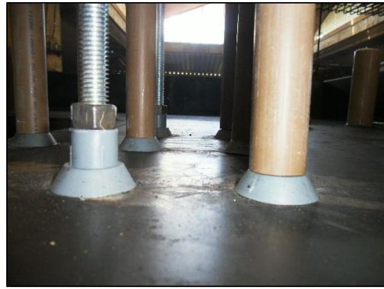
b) Detalhe da fixação dos tubos de PVC
