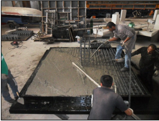
c) Início da concretagem
