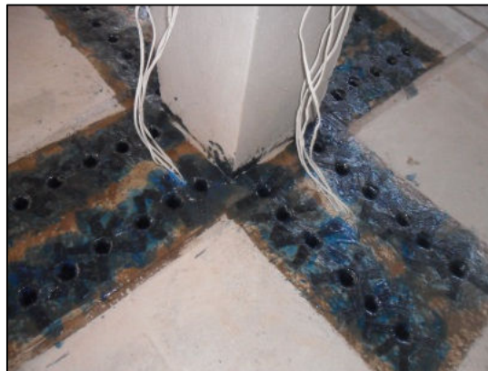
i) Laje reforçada
