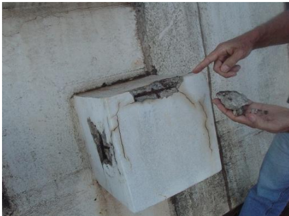
Fig. 163 - Situação do painel artístico de Athos Bulcão em 2006, antes da substituição das peças. Fonte: SECULT.
