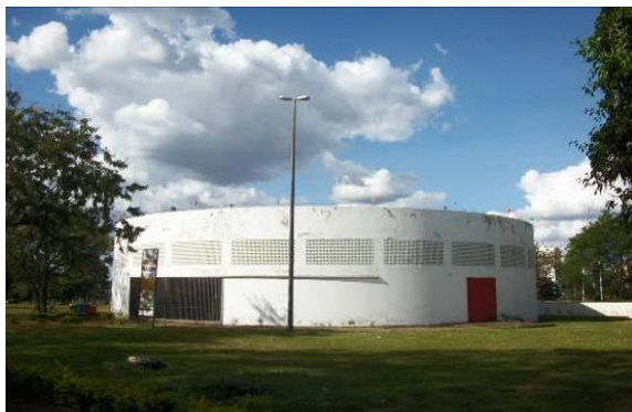
Fig. 173 - Casa do Teatro Amador, atual Teatro Funarte Plínio Marques, em Brasília, 1988.
