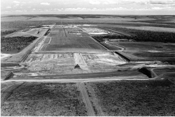
Fig. 74 - Esplanada dos Ministérios em obras no ano de 1958. Fonte: ARPDF/Mário Fontenele.
