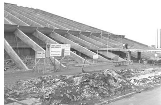
Fig. 130 - Teatro Nacional em construção, fachada principal, 1968. Fonte: ARPDF.
