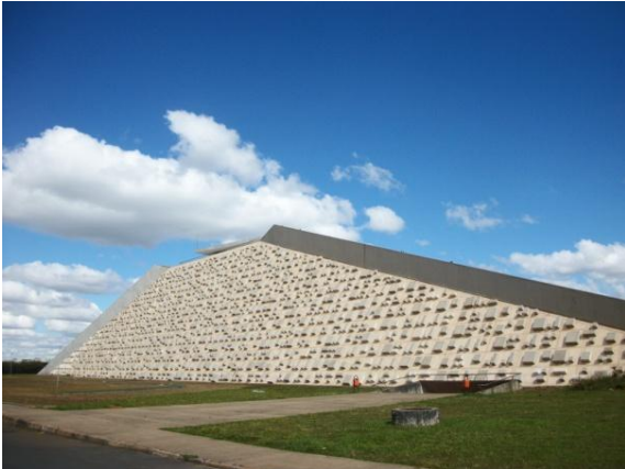
Fig. 158 - Painel de Athos Bulcão na fachada norte do prédio.
