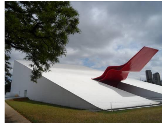
Fig. 182 - Auditório do Parque Ibirapuera, São Paulo, 2002, o segundo realizado para o prédio e inaugurado em 2005.
