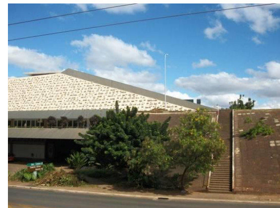
Fig. 17 - Fachada norte do TNCS, destacando o desnível e a fachada do Anexo.
