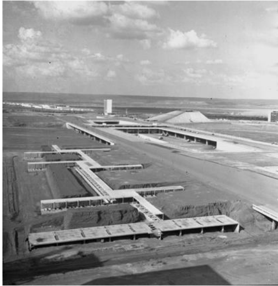
Fig. 124 - Setor de Diversões Sul em construção. Ao fundo, a Rodoviária e o Teatro, 1963. Fonte: ARPDP.
