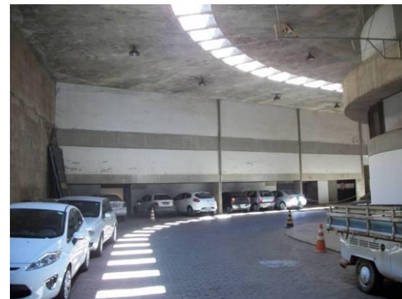
Fig. 40 - Rua de serviço interna ao prédio Anexo.
