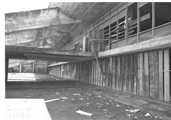
Fig. 129 - Teatro Nacional em construção, em 1976, ainda com esquadrias provisórias no foyer da Sala Villa-Lobos. Fonte: ARPDF.
