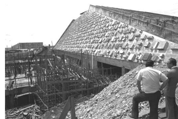
Fig. 148 - Construção do Anexo do Teatro Nacional, 1977. Fonte: ARPDP/J. Firmino.
