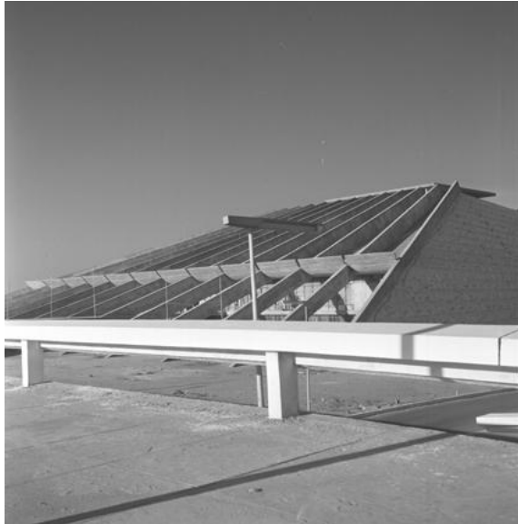
Fig. 147 - Teatro Nacional em construção em 1969. Fonte: ARPDF.
