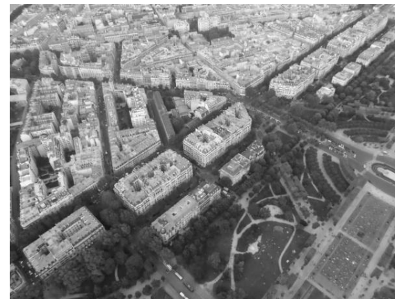
Fig. 46 - Vista aérea de Paris, com gabarito uniforme, vias cortando a cidade e vegetação típica da reforma urbana promovida por Georges-Eugène Haussmann.
