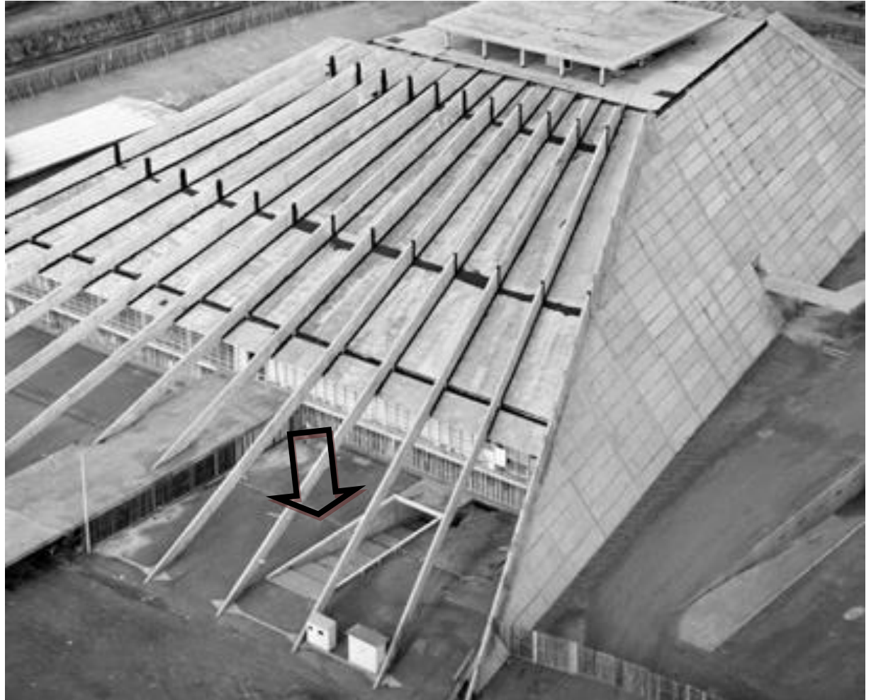
Fig. 134 - Detalhe do Teatro Nacional em construção, ainda com a escada de acesso à Sala Villa-Lobos na fachada oeste, 1965. Fonte: ARPDP.
