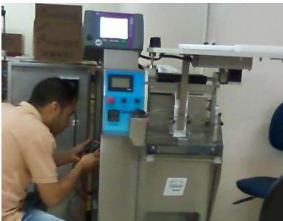
Figura 7: Instalação da OPUS PAC
