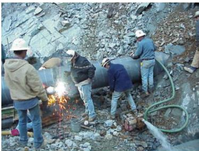
Figura 2.9: Soldagem manual de dutos (Pharris e Kolpa, 2007).
