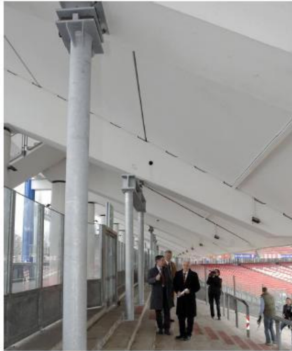
Figura 2.7 – Pilares metálicos instalados no estádio de Nurembergue – Stempniewski et al (2010)
