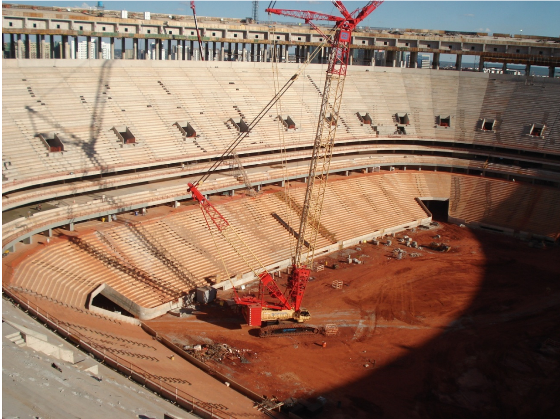
Figura 6.6 – Foto interna do Estádio Nacional durante construção – nível da arquibancada superior
