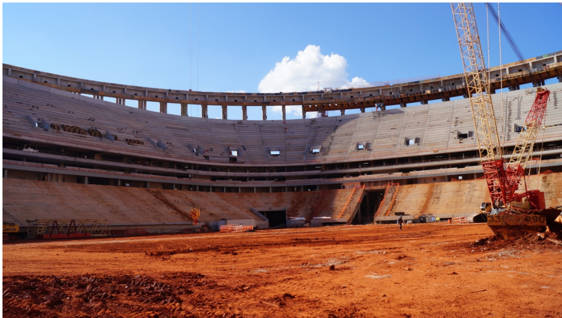
Figura 6.5 – Foto interna do Estádio Nacional durante construção – nível do campo
