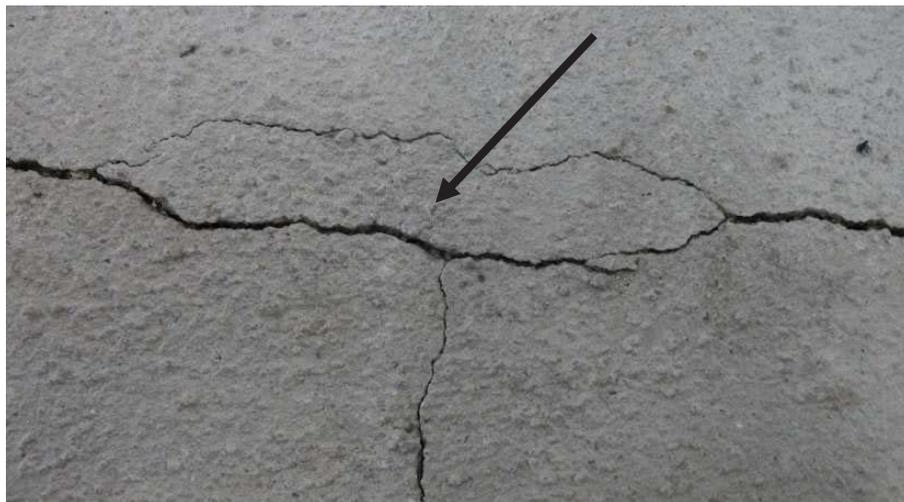
Figura 4.26: Detalhe de uma região fissurada do painel, com pedaço de argamassa com deficiência de aderência à estrutura de bambu.
