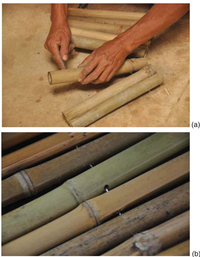
Figura 3.28: As imagens demonstram o momento da união das varas de bambu, com o auxílio de arame galvanizado.
