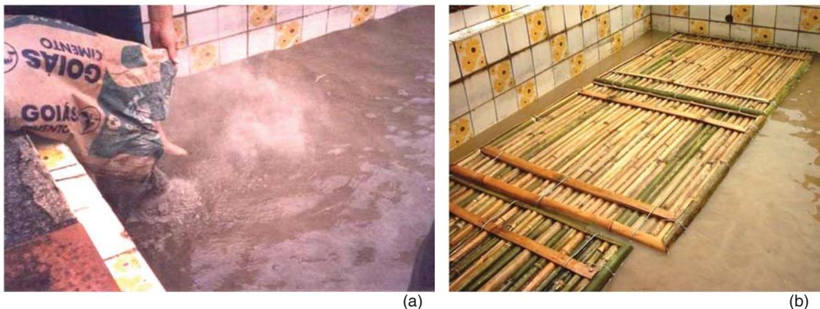
Figura 3.12: Imagem da calda de cimento sendo preparada no tanque (a) e das estruturas de bambu imersas na calda de cimento (b).
