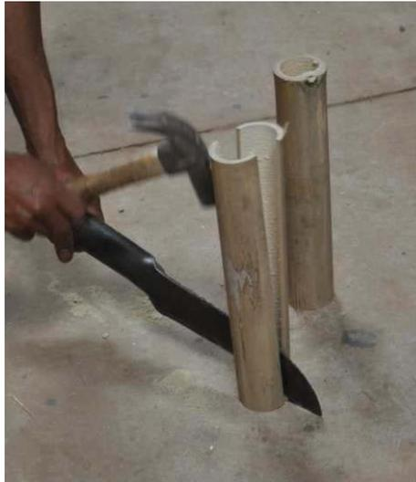
Figura 3.26: Imagem da abertura do bambu ao meio, para preparação das molduras dos painéis de bambu.
