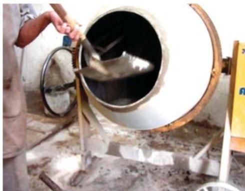
Figura 3.15: Preparação da argamassa de chapisco, com o auxílio de betoneira.
