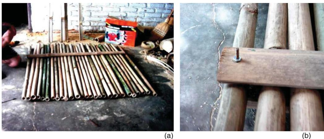
Figura 3.10: As travessas de bambu são colocadas por cima e por baixo das varas de fechamento(a); Posteriormente, as travessas são parafusadas nas varas de bambu (b).
