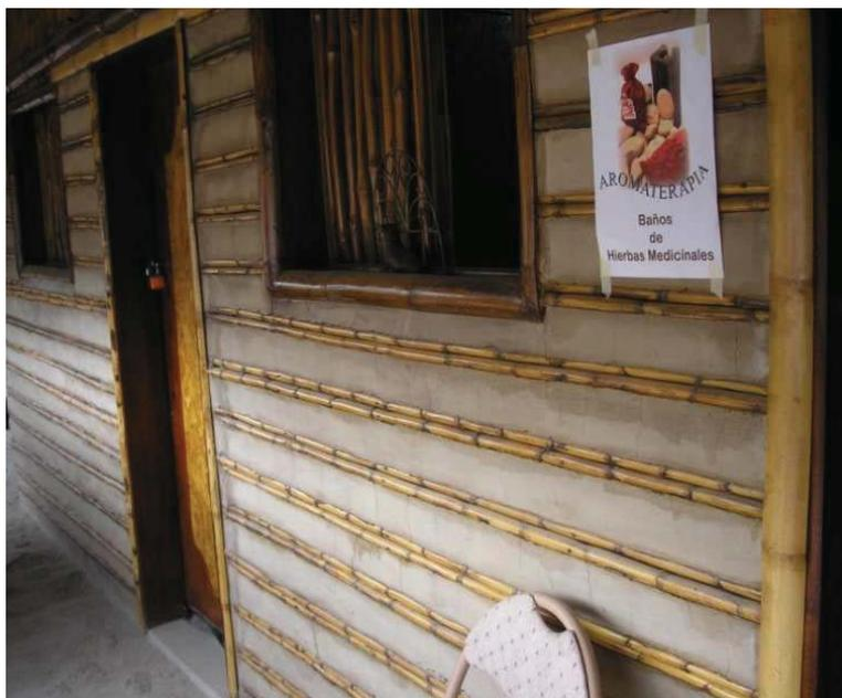
Figura 1.27: Painel de vedação feito com bambus e terra crua.
