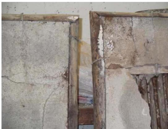
Figura 4.28: Aspecto visual das molduras dos painéis de bambu, com degradação aparente.
