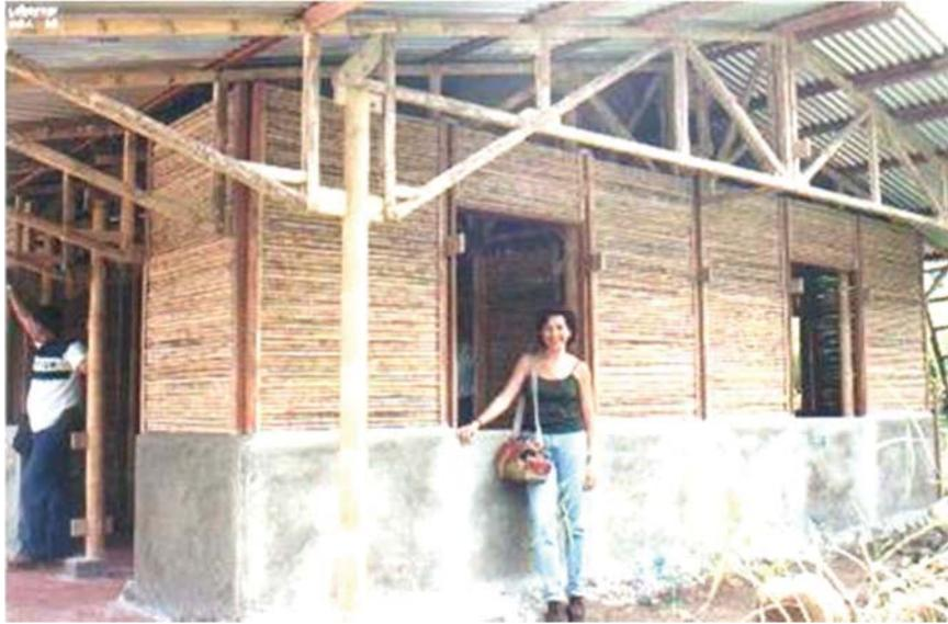
Figura 2.10: Casa pré-fabricada de bambu (*Kit Casa Pronta*), comercializada na Costa Rica (1988).
