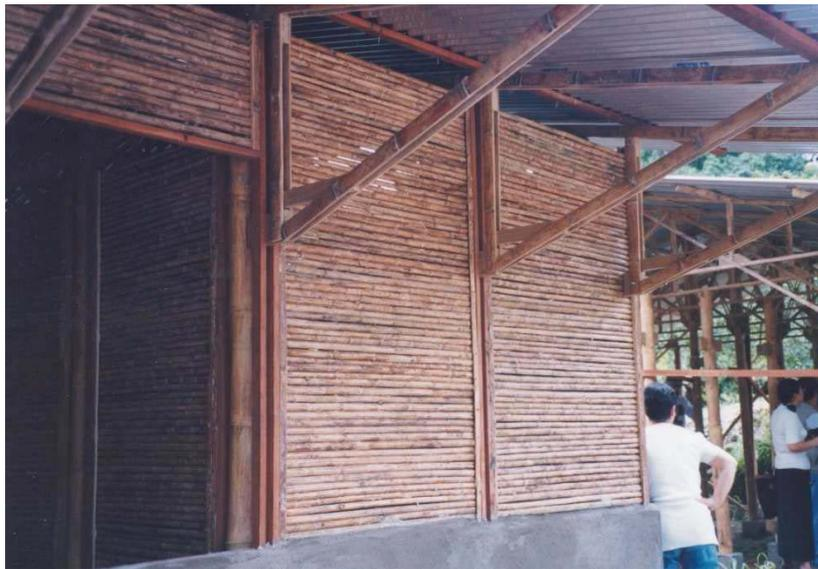
Figura 2.11: Detalhe do painel de bambu utilizado na casa pré-fabricada de bambu (*kit casa pronta*), antes da aplicação da argamassa de revestimento.
