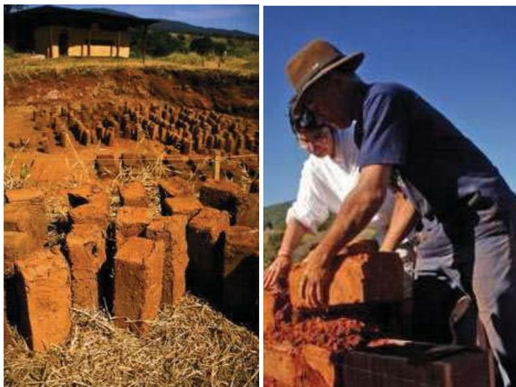
Figura 1.6 (a e b): Tijolos de adobe sendo aplicados em alvenaria. Fonte: ECOCENTRO, 2012.
