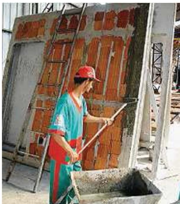
Figura 1.23: Painéis de blocos cerâmicos empregados na produção de habitações econômicas. Fonte: TÉCHNE, 2013.
