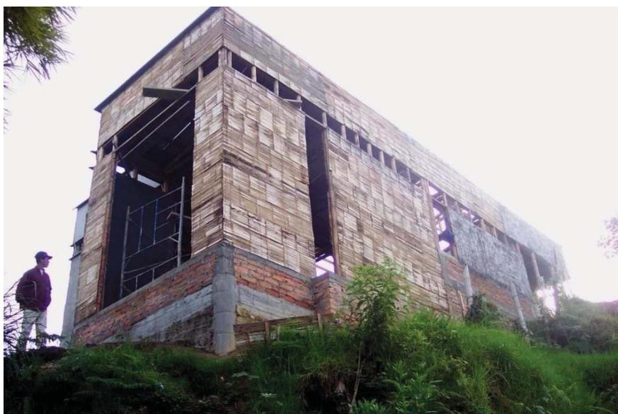
Figura 1.30: Casa Santander, na Colômbia. Construção com o uso de painéis de bambu em forma de esteira. Fonte: ACFA, 2005.
