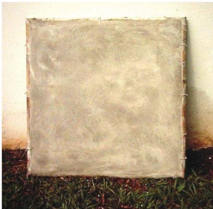
Figura 4.24: Aspecto visual inicial do painel de bambu argamassado, executado no ano de 2005.
