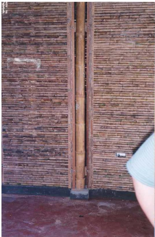
Figura 1.28: Pannel de vedação com moldura de madeira e preenchimento com bambus finos.
