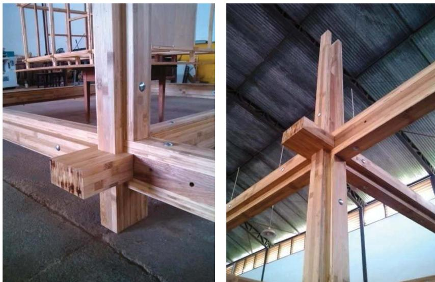
Figuras 1.18 e 1.19 Pilares feitos com bambu laminado, colados e aplicados em protótipo de habitação econômica, projeto desenvolvido pelo CPAB/UnB.
