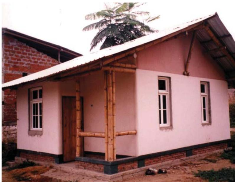
Figura 1.29: Edificação construída com painéis de bambu, que foram revestidos com argamassa nas fachadas externas. Fonte: TEIXEIRA, 2006.
