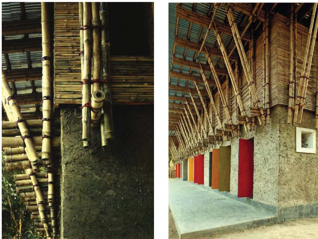
Figuras 1.4 e 1.5: Detalhes construtivos da *Handmade School*, evidenciando o uso de materiais de baixo impacto ambiental como o bambu e a terra crua.
