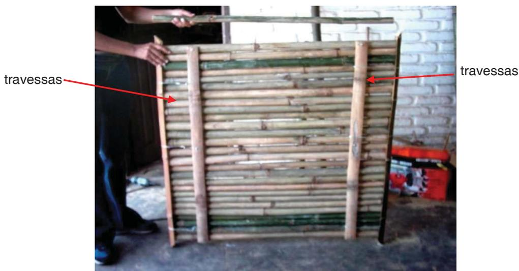
Figura 3.8: Travessas de bambu (*Dendrocalamus giganteus*) utilizadas na fixação das varas de fechamento ao painel.
