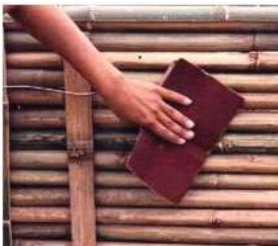
Figura 3.11: Toda a superfície da estrutura de bambu é lixada, a fim de promover maior aderência entre os bambu e a argamassa de revestimento a ser aplicada.
