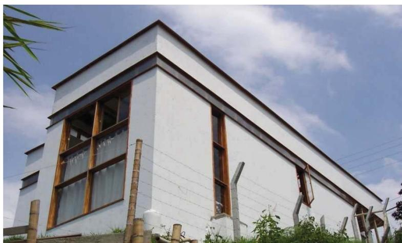
Figura 1.31: Imagem da utilização de painéis de bambu na forma de esteira, após a aplicação da argamassa. Fonte: ACFA, 2005.
