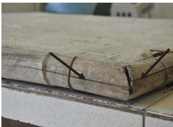
Figura 4.29: Detalhe das molduras de bambu, com degradação aparente.
