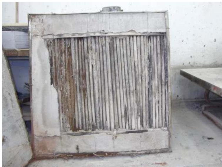
Figura 4.30: Painel com remoção parcial da argamassa de revestimento, podendo se ver o aspecto superficial.
