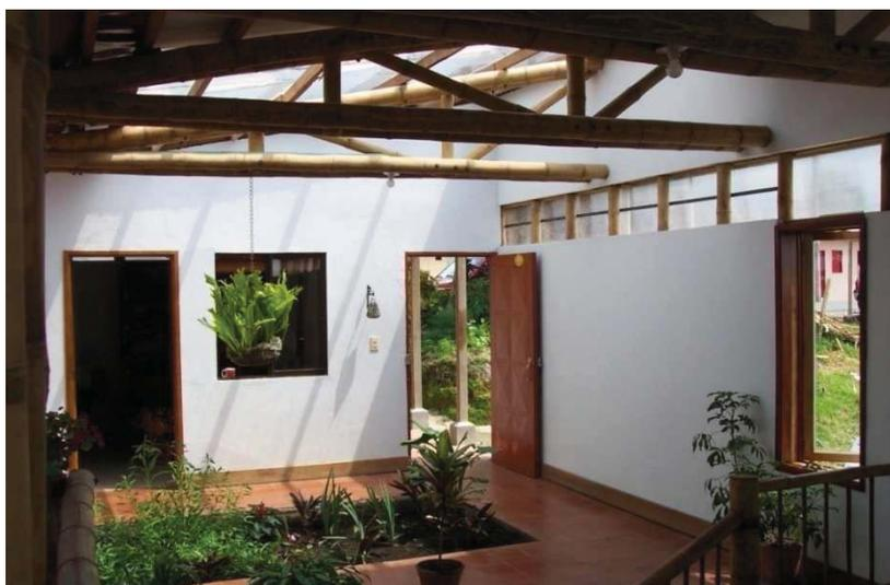
Figura 1.32: Casa feita com painéis de bambu, argamassados nas faces externa e interna.
