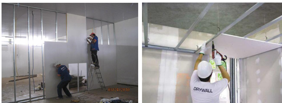
a) Instalação de divisórias de CGA
