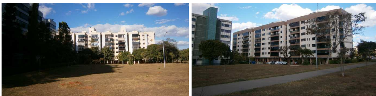
Figura 78 – Fotos da superquadra 209N. À esquerda, área livre no lado sul da quadra e no lado oeste (paralelo ao Eixo Rodoviário).
