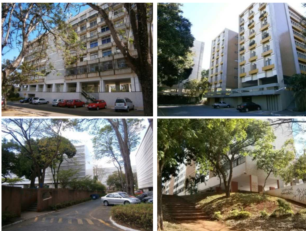
Figura 57 – Desníveis entre o piso térreo dos blocos e os espaços públicos das superquadras 109S, 207S, 308S e 113N, respectivamente, da esquerda para direita e de cima para baixo.
