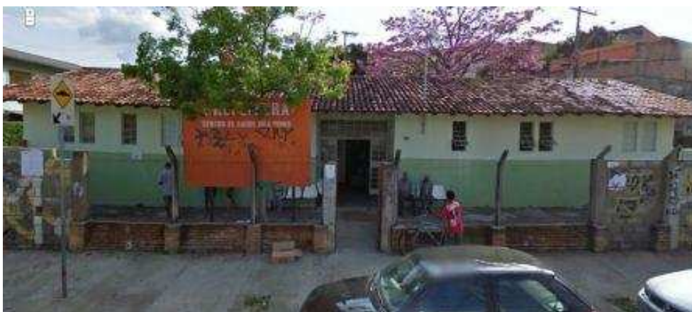
Figura 11: Centro de Saúde de Belo Horizonte de construção antiga
