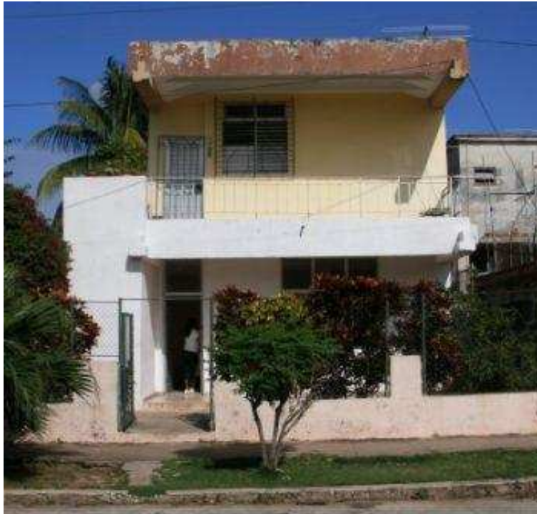
Figura 12: Consultório de Médico da Família de Havana em edificação clássica
