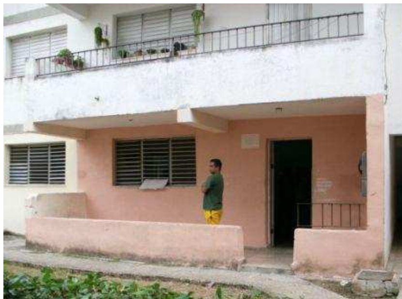
Figura 13: Consultório de Médico da Família de Havana em edifício residencial
