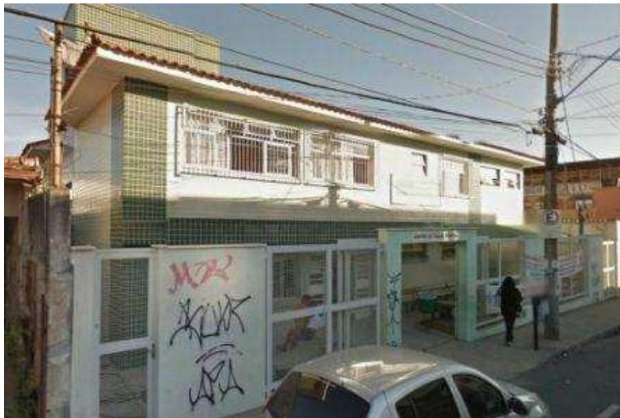
Figura 10: Centro de Saúde de Belo Horizonte de construção recente
