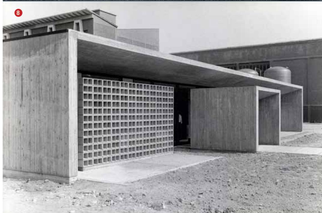
destacar-se excessivamente ou com elas contrastar. A estrutura é constituída por muros portantes e vigas e pilares de concreto armado, enquanto a cobertura foi realizada com elementos pré-fabricados de concreto protendido de modo a assegurar uma rápida execução<sup>20</sup>.
