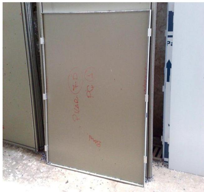
Figura 3.8 – Bandeja feita com o Painel de ACM pronta para instalação
