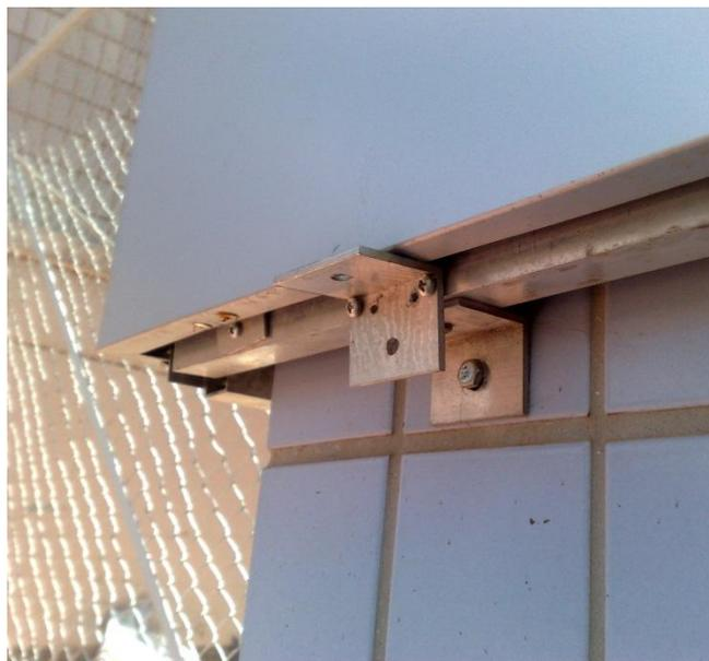
Figura 3.10 – gabarito usado para o alinhamento dos painéis de ACM
