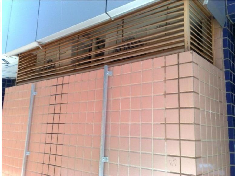
Figura 3.9 – Perfil de alumínio fixado com cantoneira de alumínio (subestrutura)
