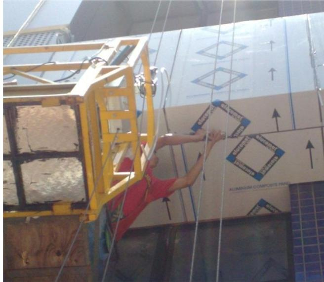
Figura 3.11 – Aplicação do silicone nas juntas de dilatação dos painéis.
