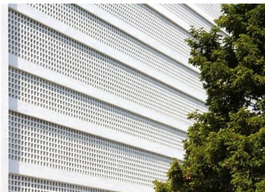
Figura 26 e Figura 27– Exemplos de Cobogós (Fonte: evolutivaarquitetura.wordpress.com. Foto: Evolutiva Arquitetura).
