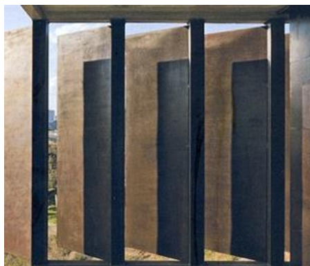
Figura 24 – Exemplo de um brise ou protetor solar vertical: casa em Nova Lima projetada por Arquitetos Associados (Fonte: www.cbca-acobrasil.org.br . Foto: Leonardo Finotti).
