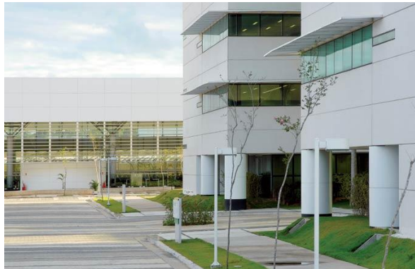
Figura 25 – Exemplo de um brise ou protetor solar horizontal – Complexo Administrativo da Petrobras em Macaé, RJ. (Fonte: www.arcoweb.com.br . Foto: Patrícia Cardoso).
