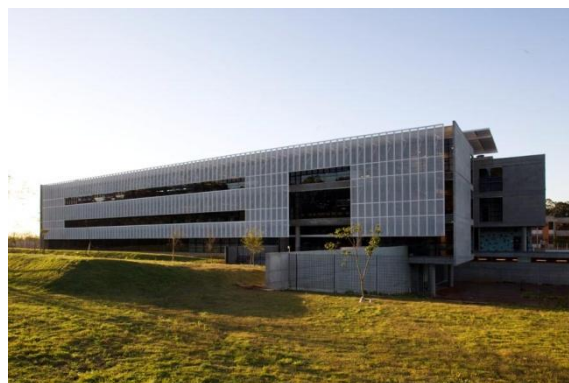
Figura 21 – Fachada do edifício SAP Global Service Center com pele dupla (Fonte: www.archdaily.com.br . Foto: Nelson Kon).
