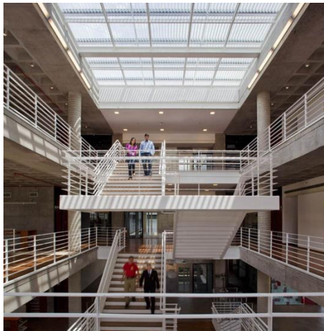
Figura 17 - Edifício com átrio - SAP Global Service Center (Fonte: www.archdaily.com.br . Foto: Nelson Kon).
