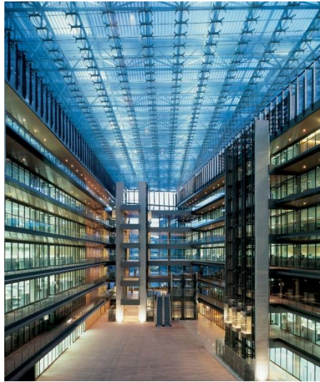
Figura 35 - Exemplo de Cobertura Translúcida (Fonte: www2.dupont.com . Foto: Safety Glass).
