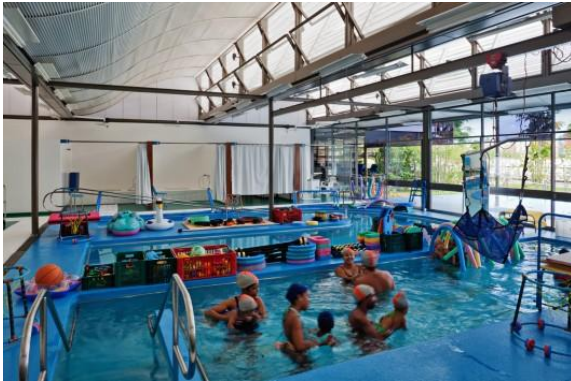
Figura 33 e Figura 34- Exemplo de Uso do Shed ou Dente de Serra (Fonte: www.archdaily.com.br . Foto: Nelson Kon).
