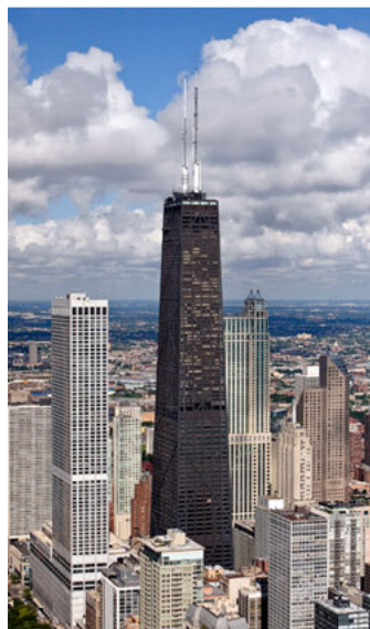
Figura 2.4 - Edifício John Hancock Tower
