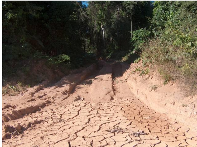
Figura 4.3 - Estradas internas danificadas por utilização no período chuvoso
