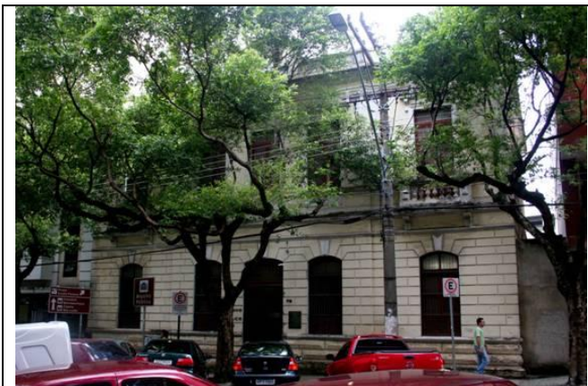
Figura 5: Edifício-sede do Arquivo Público Estadual do Espírito Santo (Fonte: sítio eletrônico do Arquivo Público Estadual do Espírito Santo)
