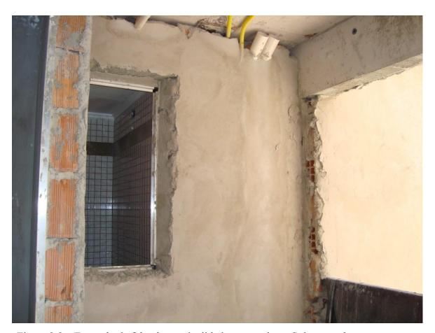
Figura 2.8 – Exemplo de falta de terminalidade em serviços. Colocação de contramarco e requadração de janela com problemas de sequência (foto tirada pelo autor desta Tese).
