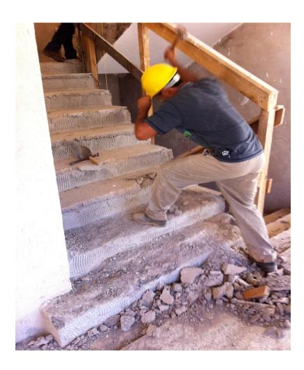
Figura 2.4 – Exemplo de retrabalho. Troca do revestimento dos degraus de uma escada (foto tirada pelo autor desta Tese).
