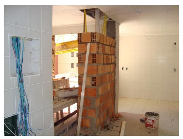
Figura 2.7 – Exemplo de falta de terminalidade em serviços. Fechamento de *shaft* é executado após término do revestimento de cozinha (foto tirada pelo autor desta Tese).
