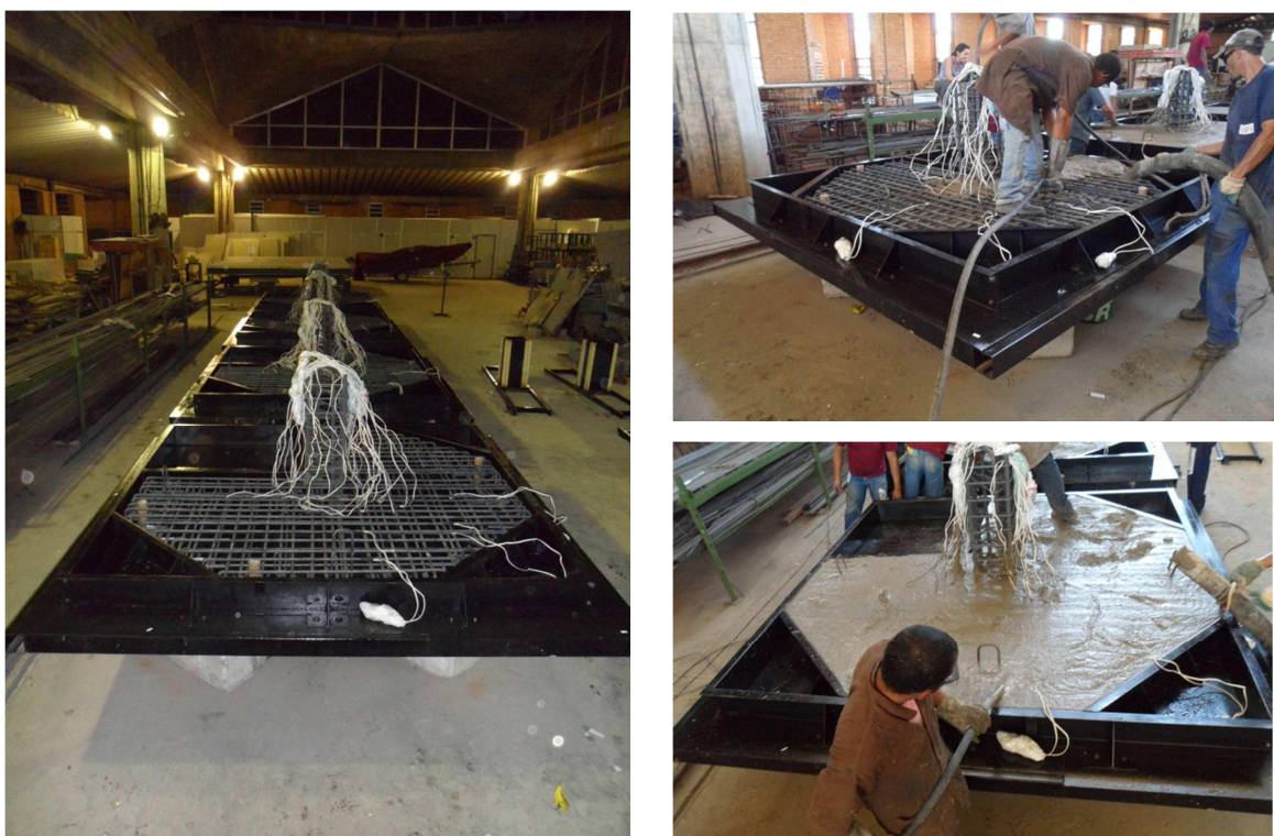
Figura 3.30 - Concretagem dos Modelos
