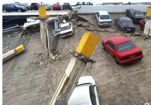
Figura 1.3 - Colapso parcial em Garagem Comercial, Christchurch CBD, Nova Zelândia (2011)
