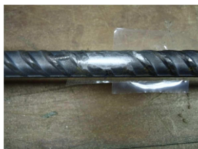
(a) Limpeza da superfície lixada
