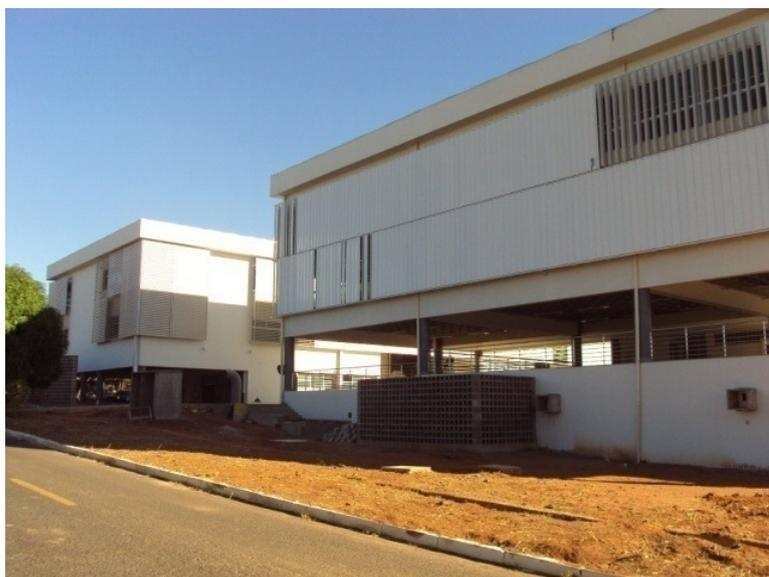
Figura 29 - Vista lateral do Bloco 50, destacando-se à direita o Bloco B e à esquerda o Bloco A. Em primeiro plano, o Bloco B onde são utilizados brises verticais, enquanto no Bloco A são utilizados brises horizontais.
