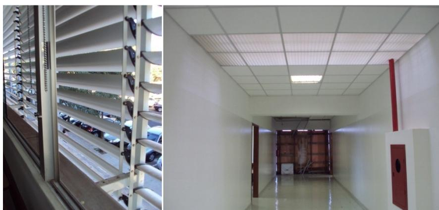
Figura 32 - Vistas internas (bloco A): à esquerda detalhe do brise horizontal das salas de aula, à direita, detalhe da iluminação zenital (fechamento em forro colméia).
