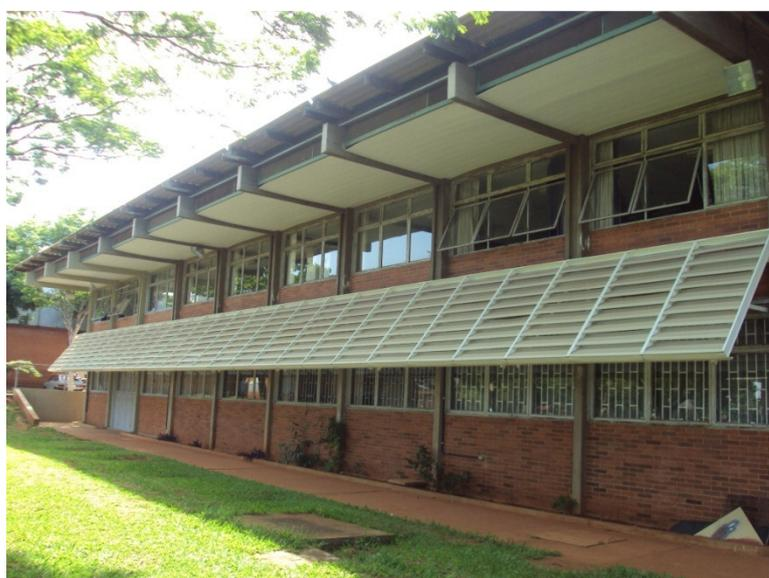
Figura 24 - Proposta de *retrofit* no Bloco 11, visando uma melhoria na iluminação natural no interior das salas de aula - Campus Santa Mônica.
