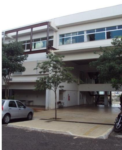
Figura 31 - Vista frontal do Bloco A, destaque para o pátio e a estrutura metálica que receberá o cobogó.
