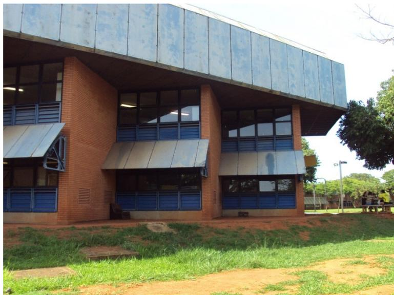
Figura 21 - Bloco 3M – Bloco dos cursos de Música e Artes cênicas. Exemplo de edifício em que houve uma preocupação com relação à adequação ao clima da cidade de Uberlândia - Campus Santa Mônica.
