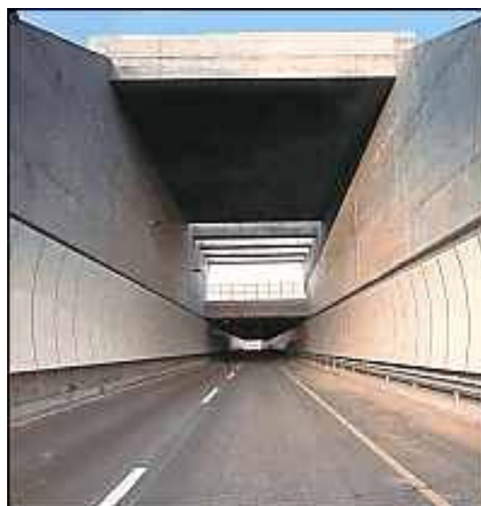
Figura 5.12 – Painéis Desde a Zona de Acesso.
