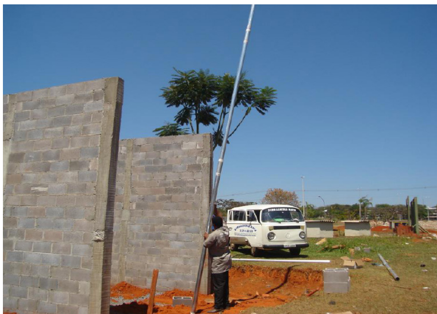
Figura 3.5. Instalação do tubo inclinômetro (Santos, 2011).
