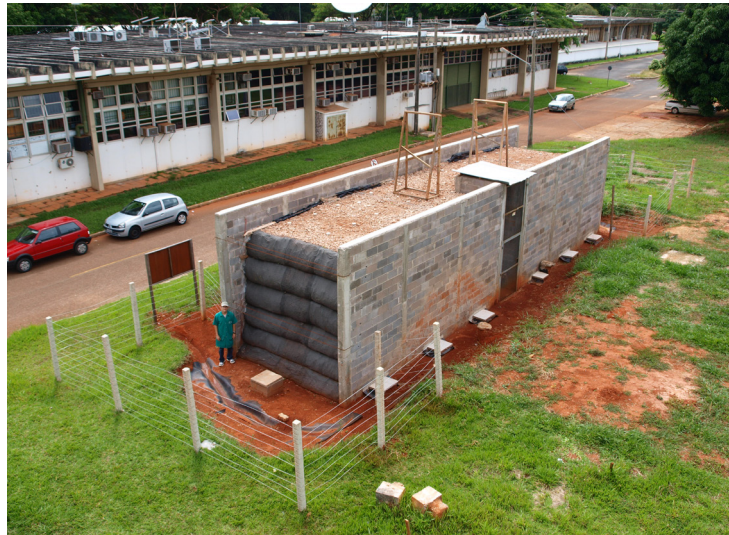
Figura 3.2. Vista geral das estruturas em solo reforçado instrumentadas (Santos & Palmeira, 2010).
