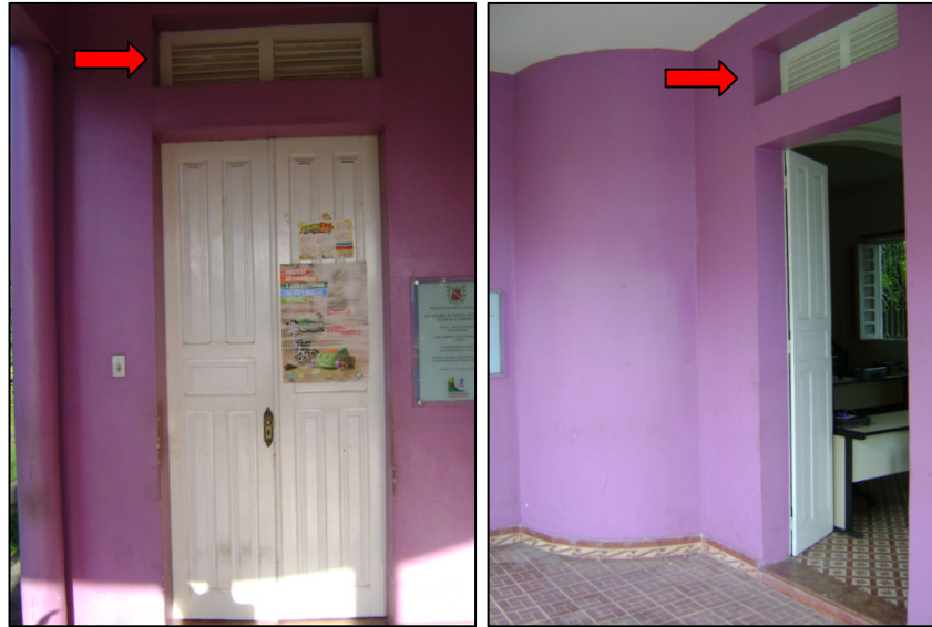
Figura 39 - Destaque para as venezianas posicionadas na parte superior das portas.
