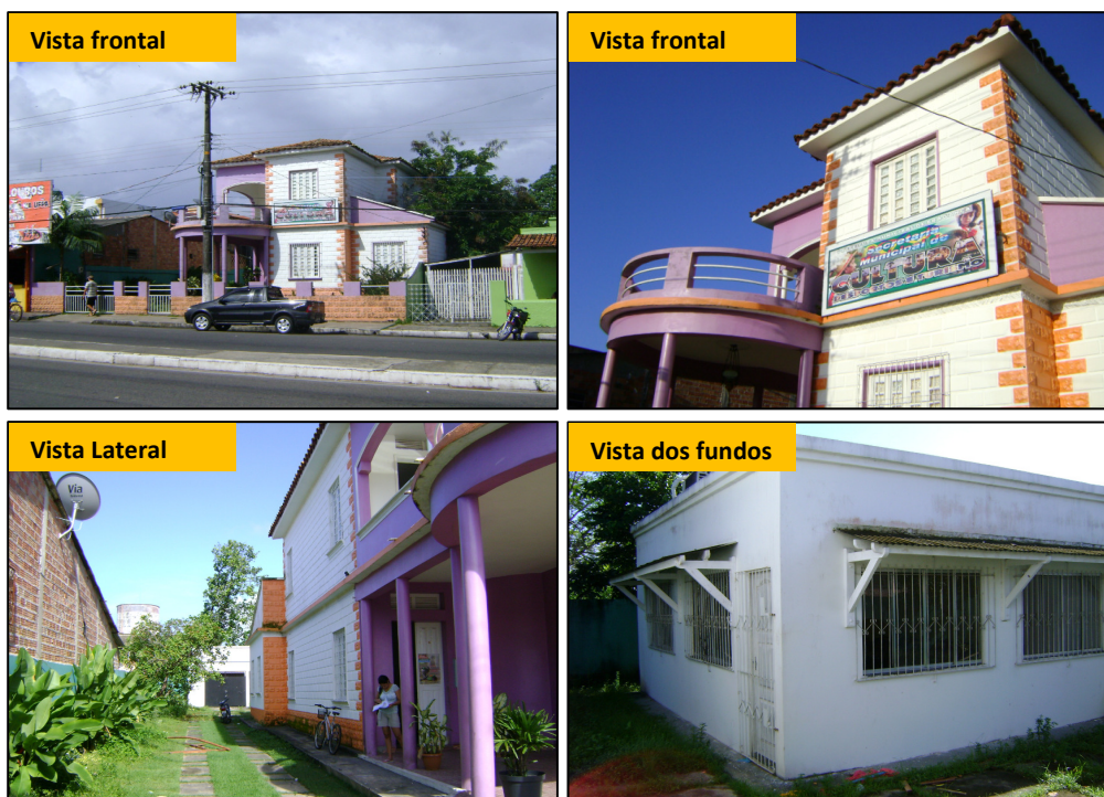
Figura 30 - Fotos do edifício da Secretaria de Cultura da cidade de Bragança – PA.
