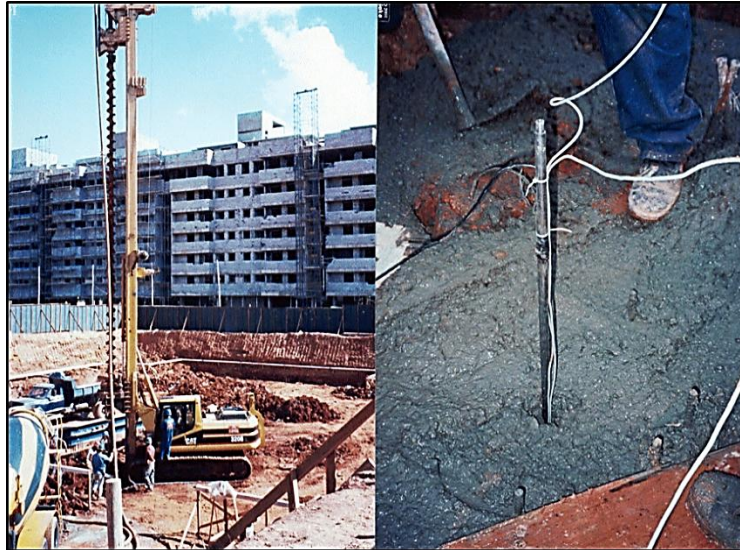
Figura 3.17 - Execução e descida da instrumentação na estaca E212G – Sítio 10.
