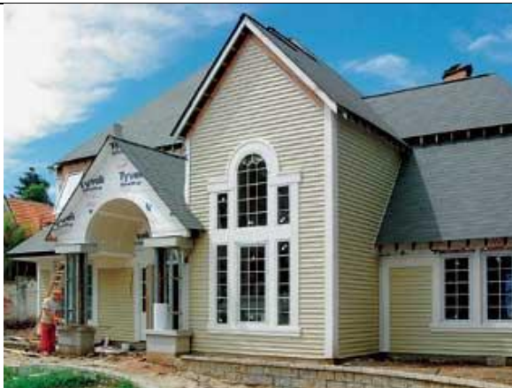
Figura 2. 43 - Casa pronta utilizando o sistema steel frame (Arcoweb,2010).
