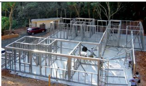
Figura 2. 40- Sistema construtivo aberto, usado com vários tipos de componentes industrializados compatíveis, o steel framing é montado depois da execução da fundação do tipo radier, sobre isolamento hidrófobo e as instalações elétricas e hidráulicas (Arcoweb, 2010).
