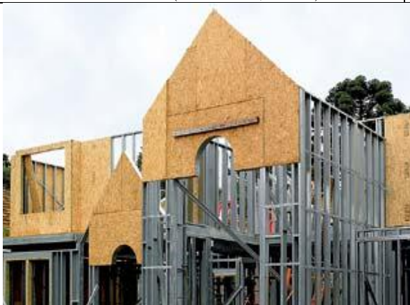
Figura 2. 40- Sistema construtivo aberto, usado com vários tipos de componentes industrializados compatíveis, o steel framing é montado depois da execução da fundação do tipo radier, sobre isolamento hidrófobo e as instalações elétricas e hidráulicas (Arcoweb, 2010).
