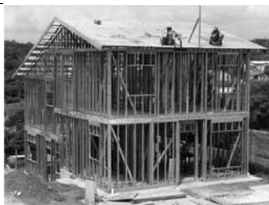
Figura 2. 33 – Montagem de residência em Light Steel Framing, São Paulo (Construtora Sequência)
