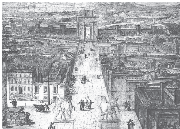
Fig. 341. A Strada Pia, em Roma. A porta desenhada por Michelangelo sobre a antiga fortificação (séc. XVI). Fonte: Kostof (2006b).
