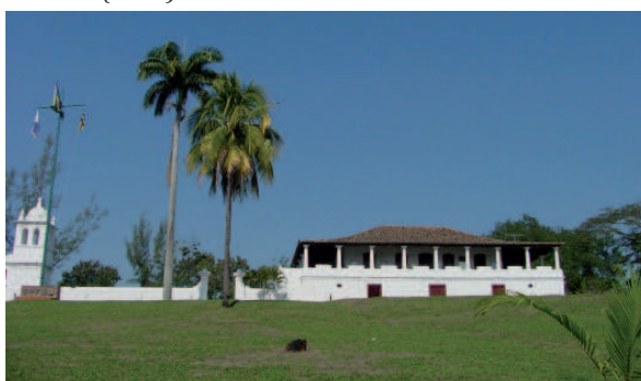
Fig. 349. A Fazenda Colubandê, no município de São Gonçalo (Rio de Janeiro). Fonte: Panoramio (2011).
