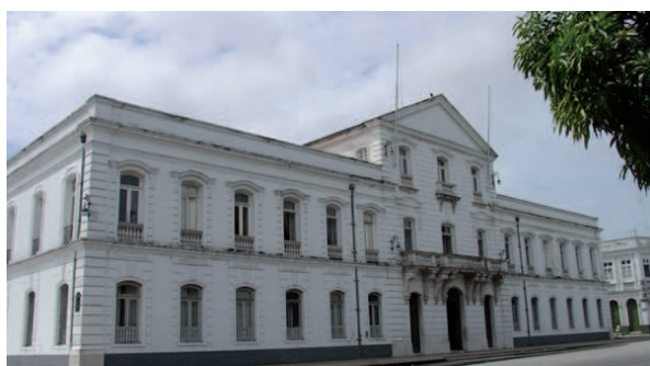
Fig. 285. O Palácio dos Governadores atualmente. Fonte: Panoramio (2011).
