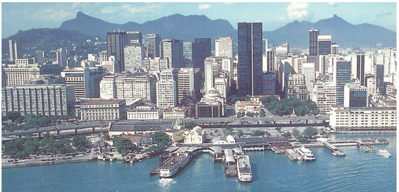
Fig. 330. Vista aérea da Praça 15 de Novembro e entorno. Fonte: Carvalho (2000).
