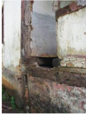
Figura 47 – Detalhe do Piso da Varanda Lateral: Barrotes e baldrame.
