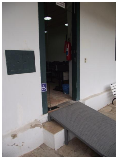
Figura 122 – Rampa Provisória com corrimão, Quartel do XX, Goiás/GO.
