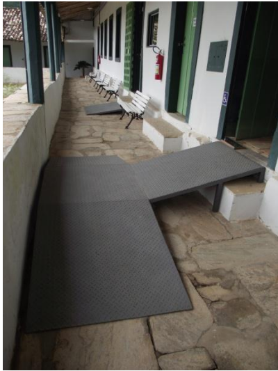
Figura 118 – Rampas metálicas na circulação.
