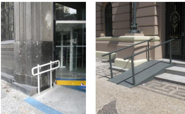
Figura 18 – Rampas e guarda-corpos provisórios e definitivos, Recife/PE. Fotos: Oscar Luís Ferreira.
