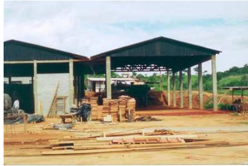
FIGURA 39. Construção da Usina de Reciclagem
