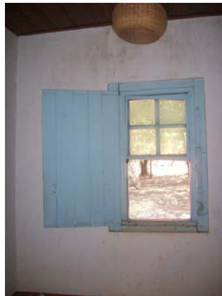
Figura 279 – Detalhe da janela com uma folha de madeira e guilhotina com vidro (Acervo PROAU/FAU/UnB).
