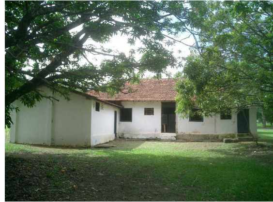
Figura 169 – Fachada dos Fundos (Foto: Vera Braun Galvão, 2005).
