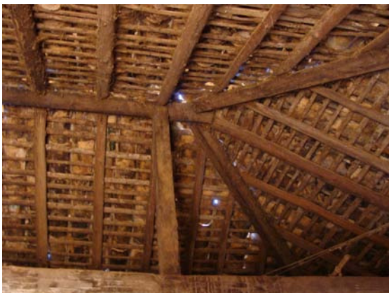
Figura 198 – Detalhe da estrutura do telhado em madeira (Acervo PROAU/FAU/UnB).
