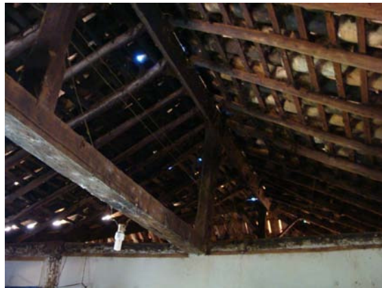
Figura 217 – Detalhe da estrutura do telhado em madeira (Acervo PROAU/FAU/UnB).
