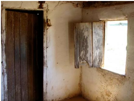
Figura 236 – Detalhe da janela e porta em madeira (Acervo PROAU/FAU/UnB).
