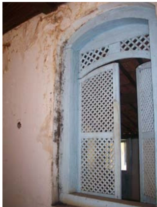
Figura 278 – Detalhe da janela treliçada (Acervo PROAU/FAU/UnB).
