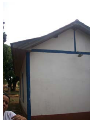
Figura 275 – Detalhe da estrutura portante de madeira aparente (gaiola) (Acervo PROAU/FAU/UnB).
