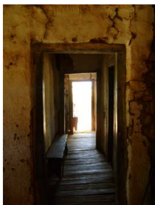
Figura 136 – Corredor interno que se estende da frente até o quintal (Acervo PROAU/FAU/UnB).
