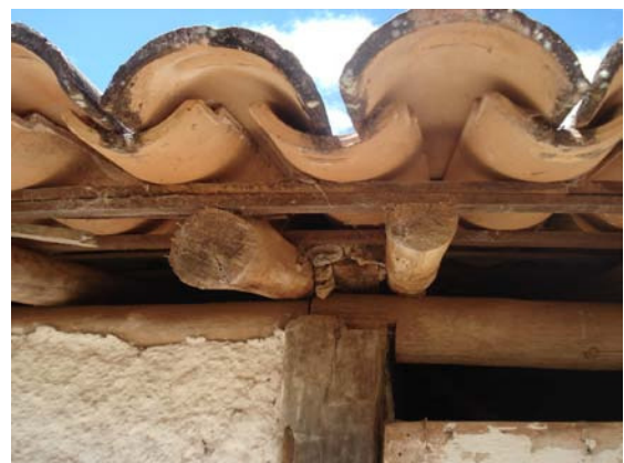
Figura 253 - Detalhe da estrutura do telhado em madeira com telhas de barro (Acervo PROAU/FAU/UnB).
