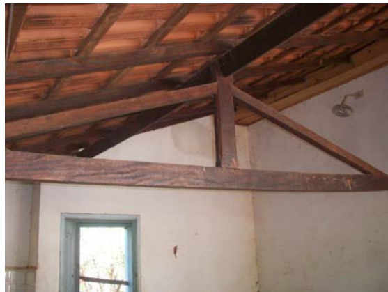
Figura 281 – Detalhe da estrutura do telhado em madeira (Acervo PROAU/FAU/UnB).
