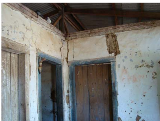
Figura 137 – Detalhe da estrutura do telhado em madeira (Acervo PROAU/FAU/UnB).
