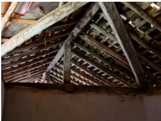
Figura 238 – Detalhe estruturado e telhado em madeira (Acervo PROAU/FAU/UnB).
