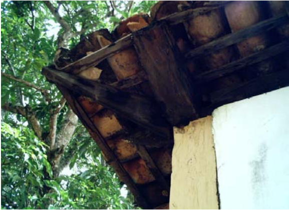
Figura 316 – Detalhe da estrutura do telhado em madeira (Acervo PROAU/FAU/UnB).
