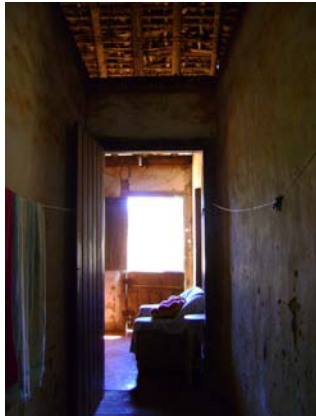
Figura 196 – Corredor interno que se estende da frente até o quintal (Acervo PROAU/FAU/UnB).
