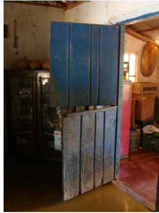
Figura 215 – Detalhe da porta de madeira (Acervo PROAU/FAU/UnB).
