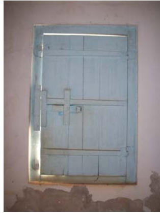
Figura 277 – Janela de madeira de uma folha (Acervo PROAU/FAU/UnB).
