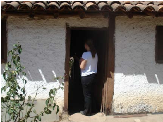
Figura 256 – Detalhe da fachada frontal, com pé direito baixo (Acervo PROAU/FAU/UnB).
