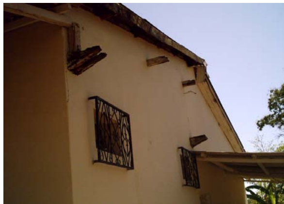
Figura 157 – Detalhe da antiga estrutura do telhado (Acervo PROAU/FAU/UnB).
