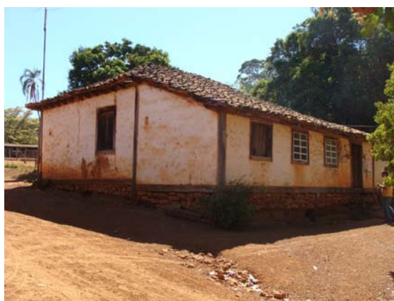
Figura 192 – Fachada lateral e fundos, vendo-se detalhe do cunhal e baldrames de madeira (Acervo PROAU/FAU/UnB).
