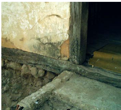
Figura 135 – Detalhe da estrutura portante de madeira aparente (gaiola) (Acervo PROAU/FAU/UnB).
