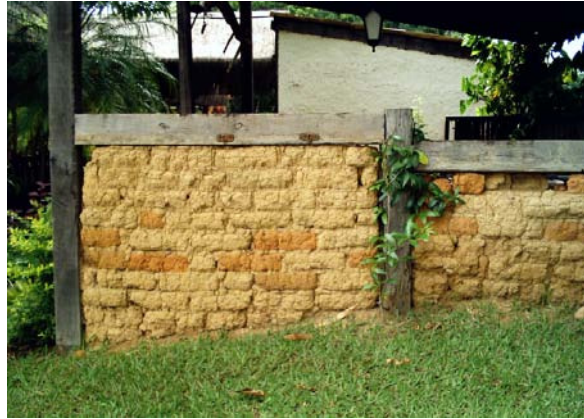
Figura 317 – Detalhe do muro de adobe (Acervo PROAU/FAU/UnB).
