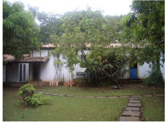
Figura 311 – Detalhe da fachada lateral (Acervo PROAU/FAU/UnB).
