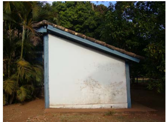
Figura 293 – Detalhe da fachada lateral (Acervo PROAU/FAU/UnB).
