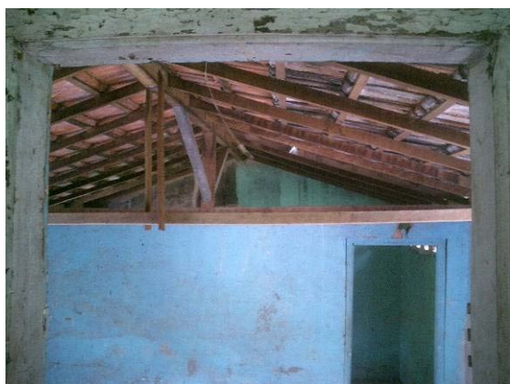
Figura 176 – Detalhe da estrutura do telhado em madeira (Foto: Vera Braun Galvão, 2005).
