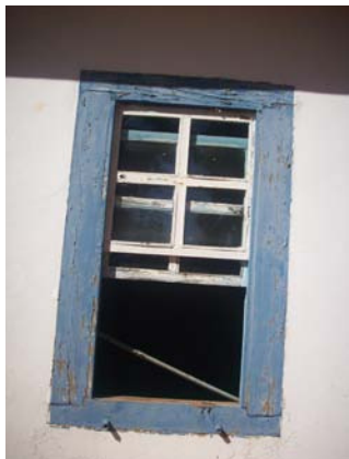
Figura 280 – Detalhe da janela de guilhotina com vidro (Acervo PROAU/FAU/UnB).
