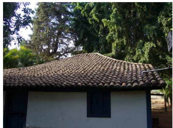
Figura 295 – Detalhe da cobertura com telhas de barro (Acervo PROAU/FAU/UnB).
