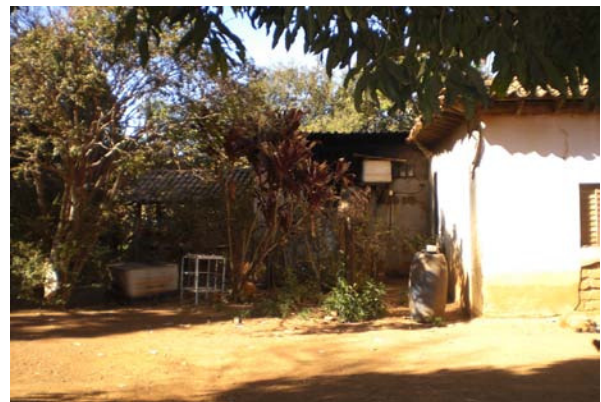
Figura 191 – Acréscimo à fachada frontal (Acervo PROAU/FAU/UnB).
