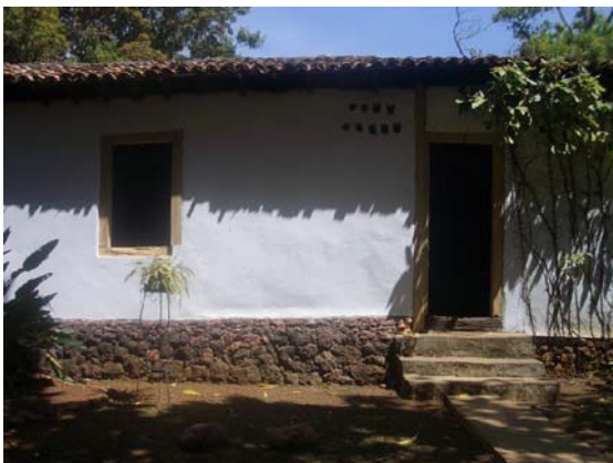
Figura 314 – Detalhe da fundação de pedra (Acervo PROAU/FAU/UnB).
