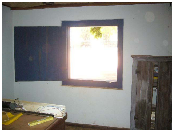
Figura 300 – Janela de madeira de uma folha (Acervo PROAU/FAU/UnB).
