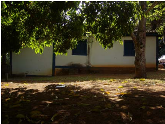
Figura 292 – Fachada lateral vendo-se o baldrame (Acervo PROAU/FAU/UnB).
