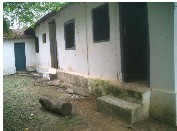
Figura 173 – Fachada dos fundos (Foto: Vera Braun Galvão, 2005).
