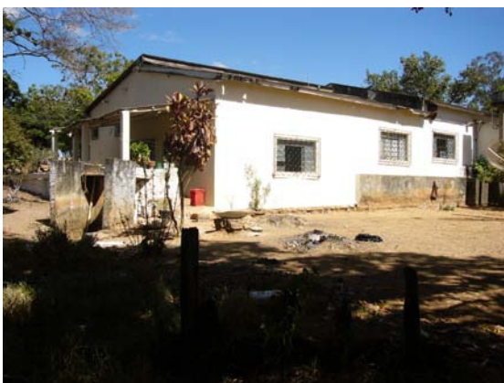
Figura 152 – Fachada lateral, vendo-se a linha divisória entre o núcleo básico e o acréscimo (Acervo PROAU/FAU/UnB).
