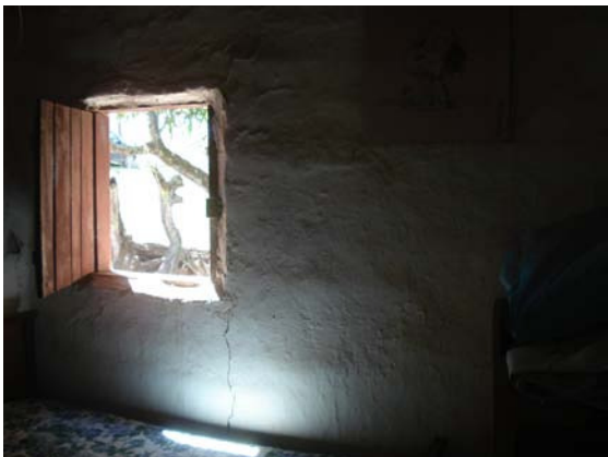
Figura 258 – Detalhe da janela de madeira de uma folha (Acervo PROAU/FAU/UnB).
