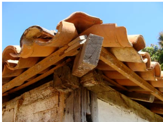
Figura 239 – Detalhe do cunhal e cobertura com telhas de barro (Acervo PROAU/FAU/UnB).
