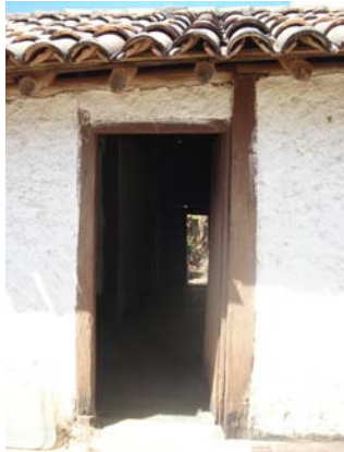
Figura 254 – Porta da frente, com detalhe da cobertura com telhas de barro (Acervo PROAU/FAU/UnB).
