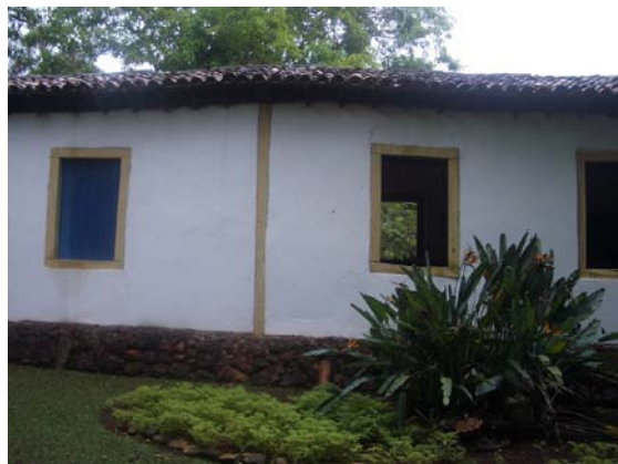
Figura 321 – Detalhe da estrutura portante de madeira aparente (Acervo PROAU/FAU/UnB).
