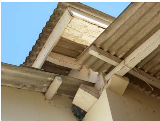
Figura 158 – Detalhe da atual estrutura do telhado sobrepondo-se a estrutura antiga (Acervo PROAU/FAU/UnB).
