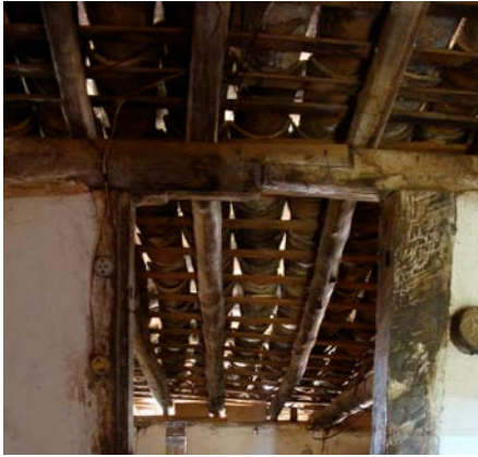
Figura 234 – Detalhe da estrutura do telhado em madeira (Acervo PROAU/FAU/UnB).
