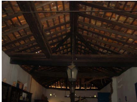
Figura 319 – Detalhe da estrutura do telhado em madeira (Acervo PROAU/FAU/UnB).
