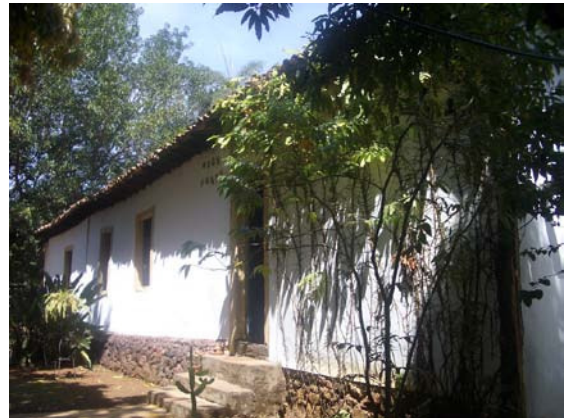
Figura 313 – Detalhe da fachada lateral (Acervo PROAU/FAU/UnB).
