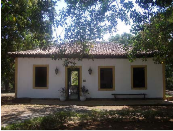
Figura 310 – Fachada frontal, vendo-se o corredor interno (Acervo PROAU/FAU/UnB).
