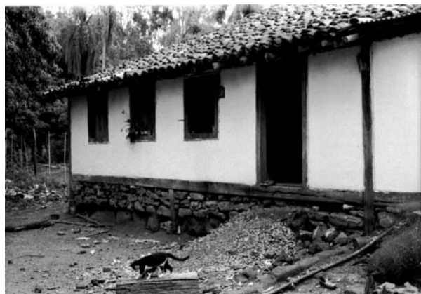
Figura 199 – Detalhe da estrutura portante de madeira aparente (gaiola) e do embasamento de pedra e terra, década de 1980 (Acervo DePHA).
