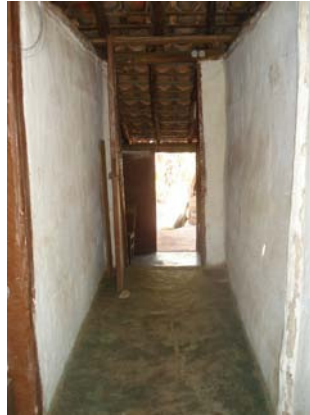
Figura 255 – Corredor interno (Acervo PROAU/FAU/UnB).
