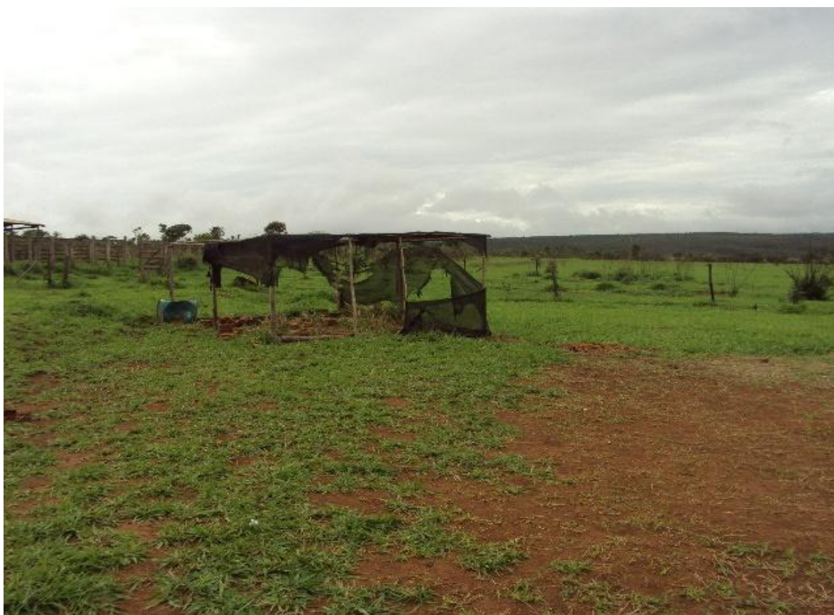
Figura 4 – Construção do Viveiro.
