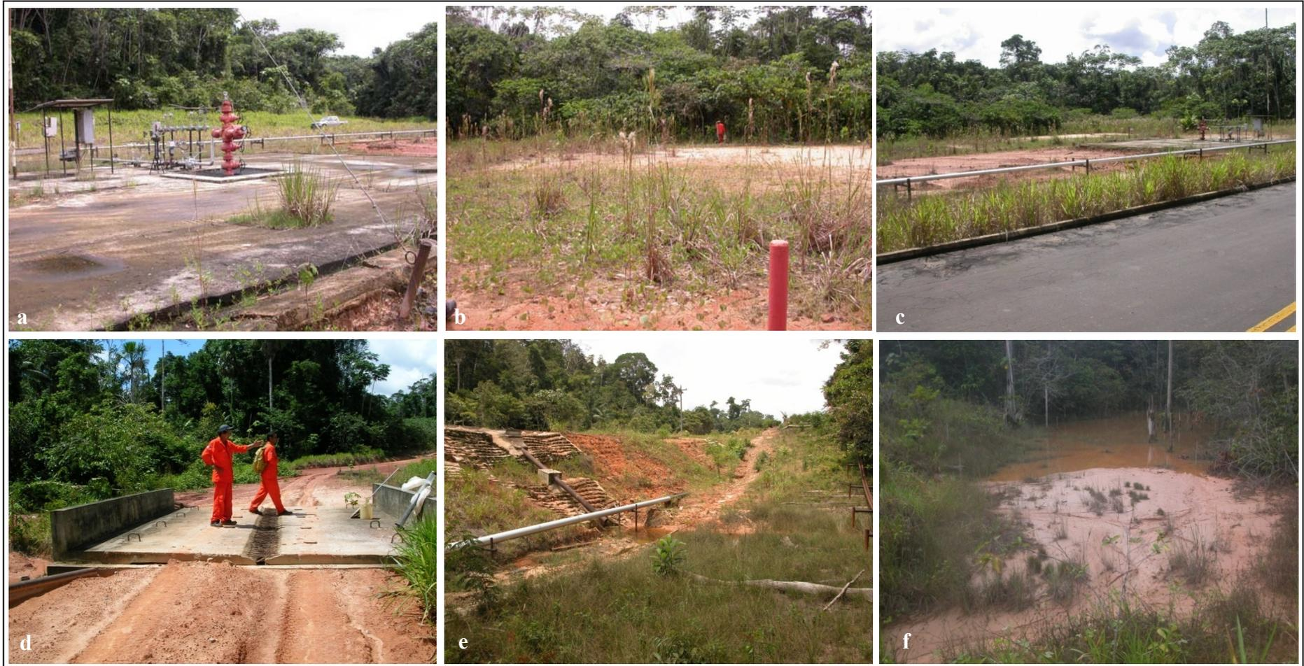
Figura 1.3 – Exemplo de fontes de sedimentos para os igarapés da Base de Operações Geólogo Pedro Moura (Coari–AM): poços (a), clareiras (b), estrada (c–d), passagem de gasoduto (e), igarapé assoreado, com interrupção do fluxo devido ao aporte de sedimentos (f).
