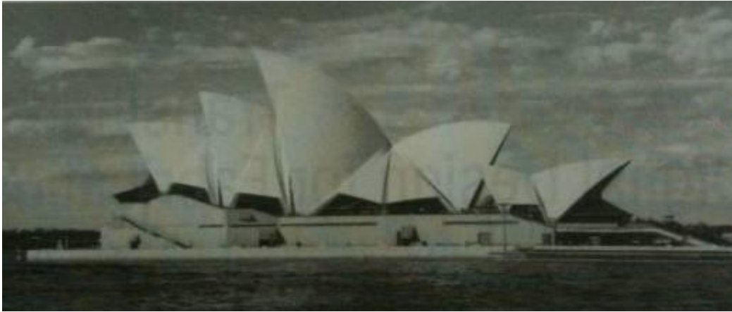
Figura 3.9 – A geometria final das cascas foi resultado da colaboração entre arquitetos e engenheiros. (SCHODEK, 2005, p. 30)
