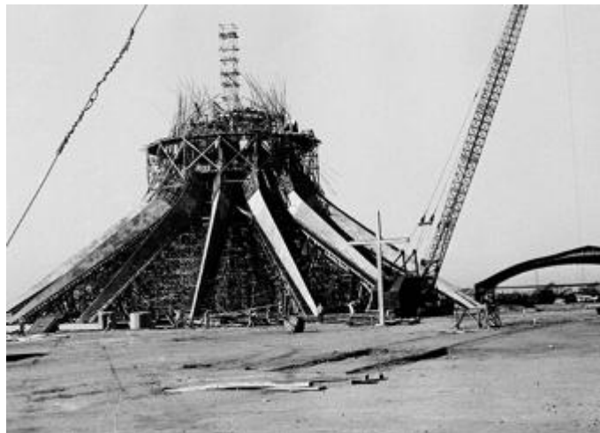
Figura 5.6. Concretagem dos pilares da Catedral de Brasília. Fonte: http://www.band.com.br/jornalismo/galeria.asp?ID=2899# , acessado em 19/12/10.
