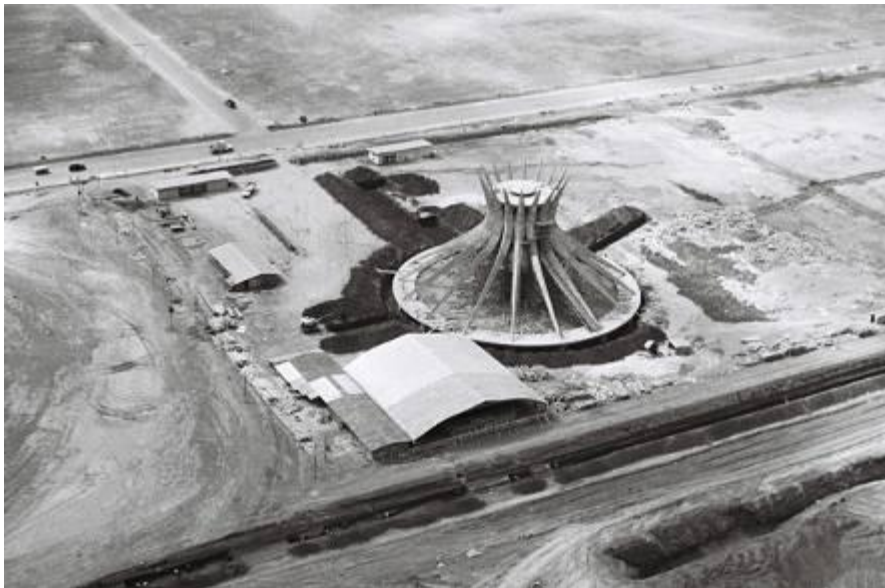
Figura 5.10. Vista aérea do canteiro de obras da construção da Catedral de Brasília. Fonte: http://www.band.com.br/jornalismo/galeria.asp?ID=2899 , acessado em 02/11/10.
