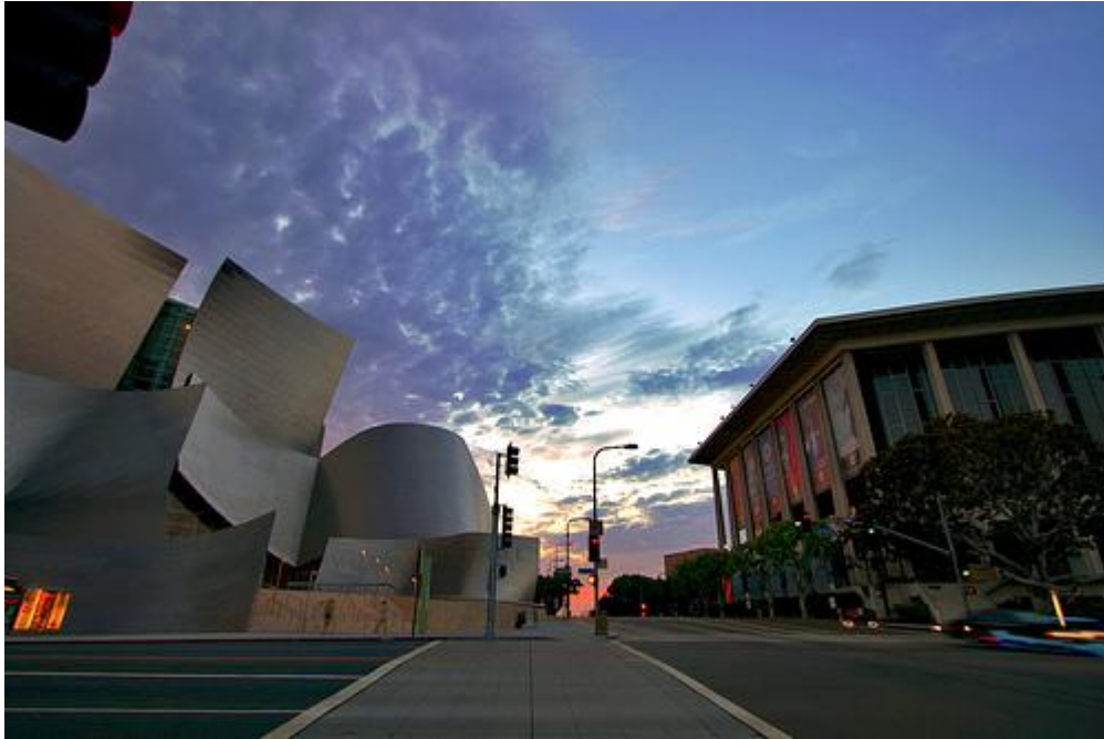
Figura 4.8b: À esquerda Walt Disney Concert Hall e à direita o Pavilhão Dorothy Chandler. Fonte: http://www.flickr.com/photos/ccmonty/1305336071/ , acessado em 13/11/10.
