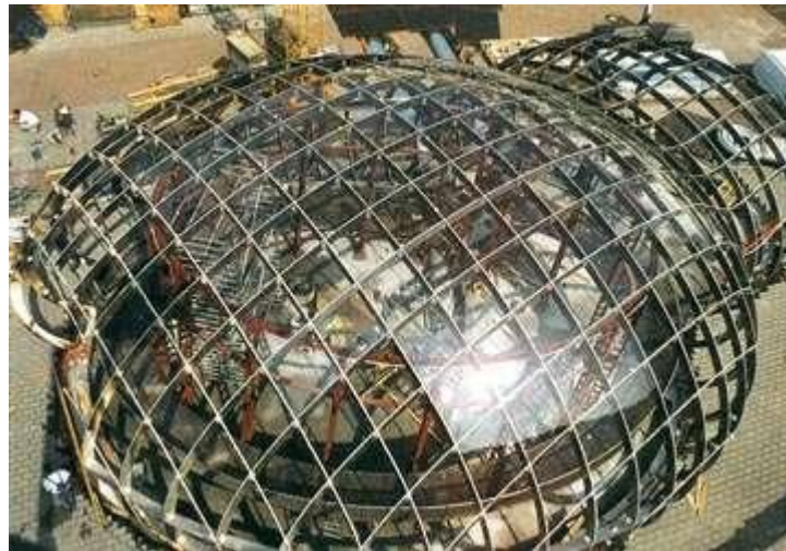
Figura 4.7. Montagem da estrutura e do vidro do “Bubble”. Fonte: http://www.era21.cz/index.asp?page_id=96 , acessado em 18/12/10.
