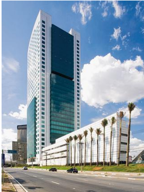
Figura 38 – Eldorado Business Center – Certificação LEED CS – Platinum. São Paulo, Brasil.
