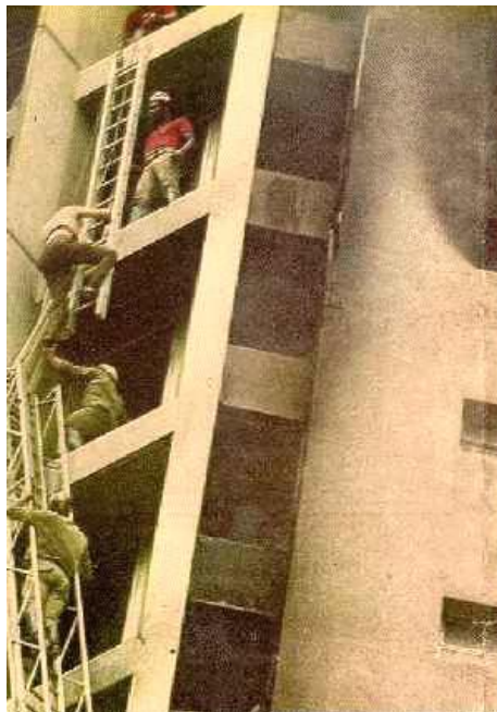
Figura 52 – Pessoas sendo resgatadas pelos bombeiros através dos banheiros do Edifício Joelma. São Paulo, Brasil.
