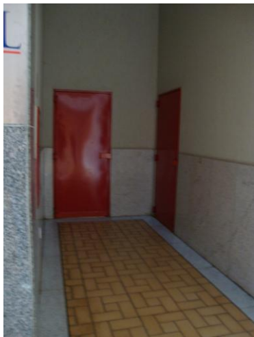
Figura 89 – Vista das portas corta-fogo com saída da escada no térreo (A) e (B).
