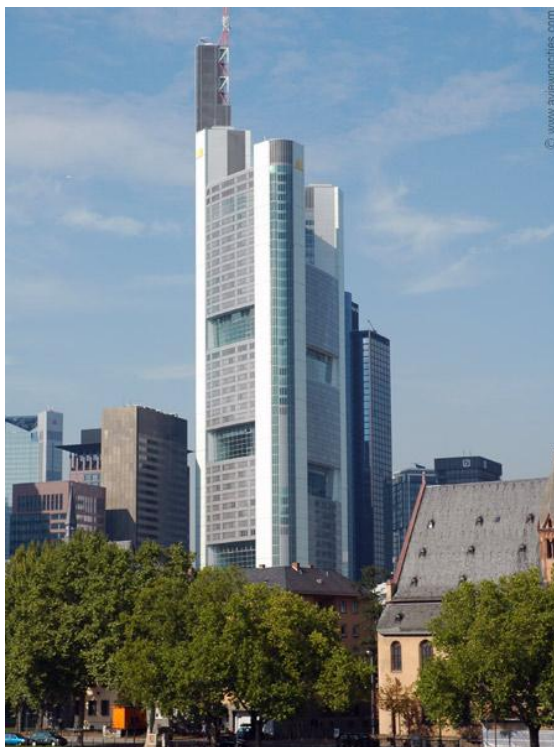
Figura 93 – Commerzbank Tower. Frankfurt, Alemanha.
