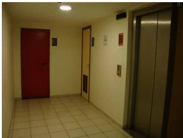
Figura 88 – Vista do hall de serviço (porta de entrada da escada + porta da lixeira + elevador de serviço).
