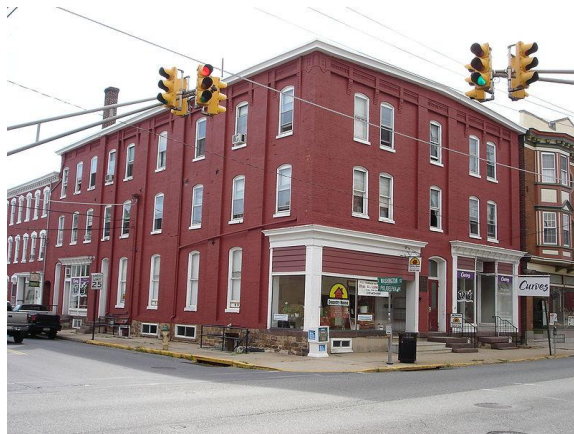
Figura 43 – Foto da Casa de Ópera Rhoades, Boyertown, EUA, de 2007.
