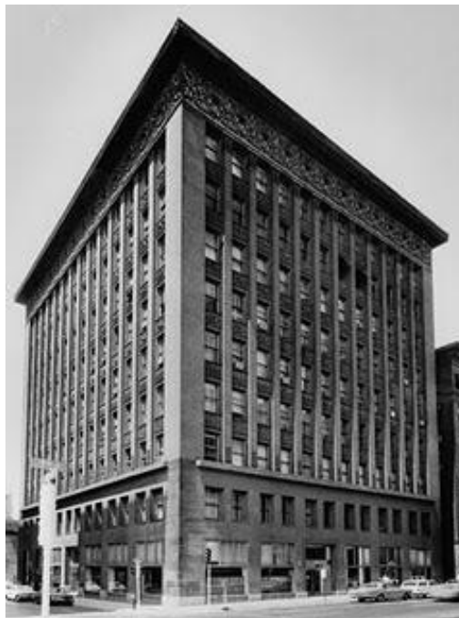
Figura 14 – Edifício Wainwright, de Louis Sullivan
