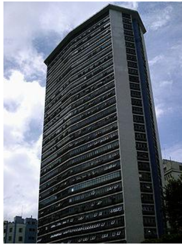
Figura 48 – Edifício Andraus após reforma. São Paulo, Brasil.
