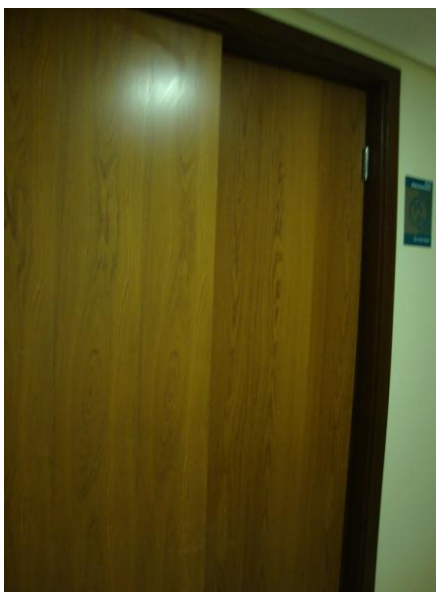
Figura 87 – Vista da porta de entrada da circulação de serviço.
