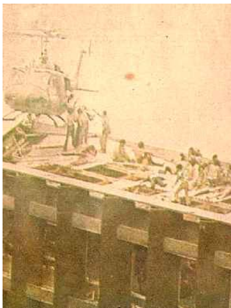
Figura 51 – Resgate pela cobertura do edifício Joelma. São Paulo, Brasil.
