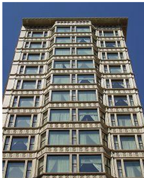
Figura 12 – Edifício Reliance, 1894. Chicago, EUA.
