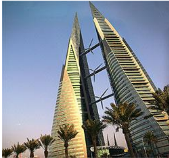
Figura 20 – Turbinas eólicas incorporadas no arranha-céu Bahrain World Trade Center.
