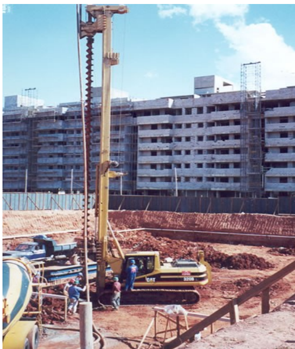
Figura 2.5 - Equipamento para execução.
