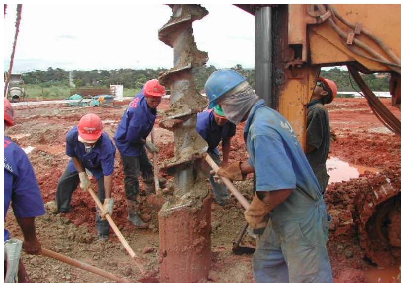
Figura 2.3 - Extração do trado e concretagem da estaca.
