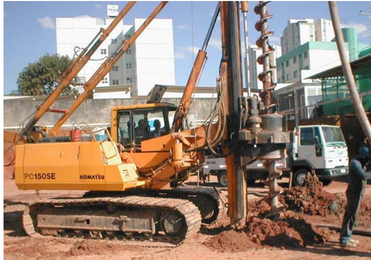
Figura 2.2 - Perfuração do terreno com trado contínuo.
