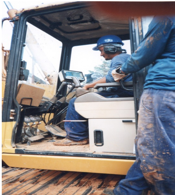
Figura 2.6 - Sistema de monitoração na cabine do operador.
