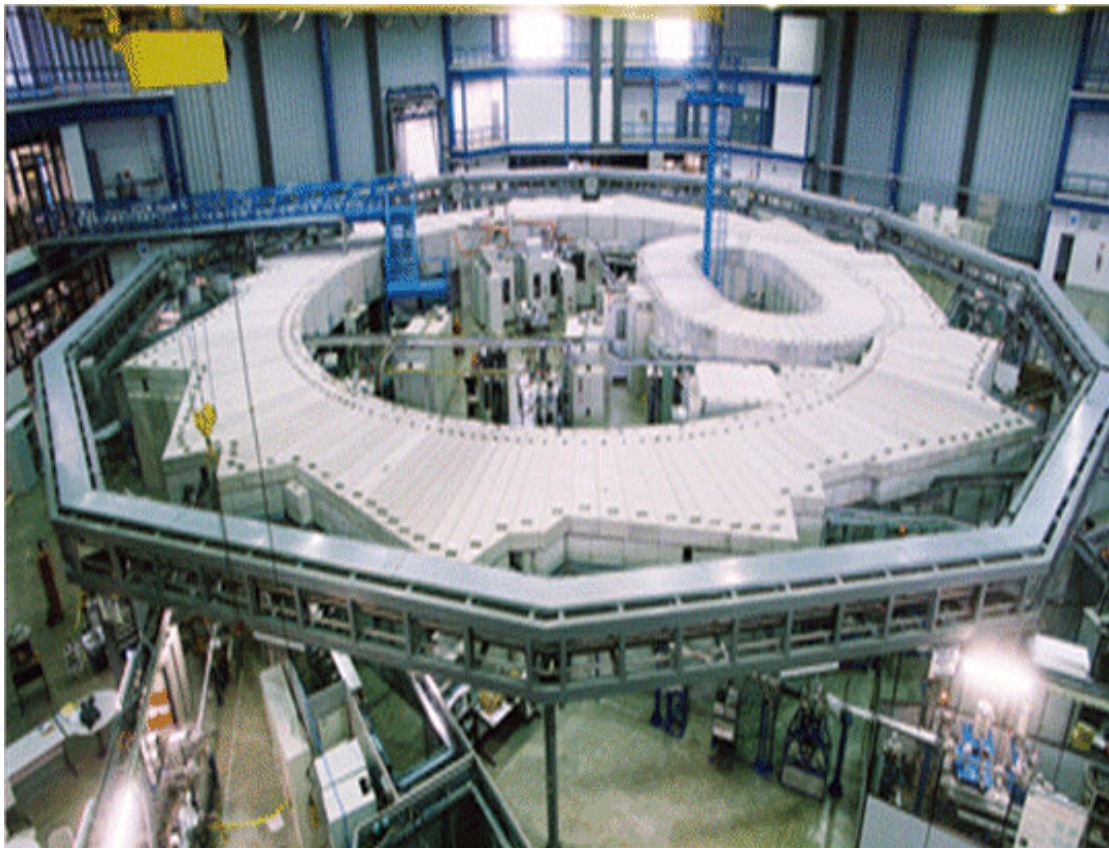
Figura 4.1 – Fotografia panorâmica do anel de luz síncrotron. A região central coberta por placas de concreto constitui o anel de armazenagem. A região em forma de elipse no interior do anel corresponde ao anel injetor ( booster ). O acelerador linear (LINAC) é subterrâneo e conecta-se ao anel através do booster. As linhas de luz saem do anel central e podem ser identificadas na figura pelos tubos metálicos correspondentes às suas linha de vácuo.
