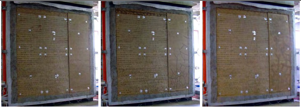
Fig. 28 – Fissuras em faixa de reboco ressaltadas durante ensaio de resistência ao fogo pela evaporação da água presente no interior da parede e posterior condensação na face externa.
