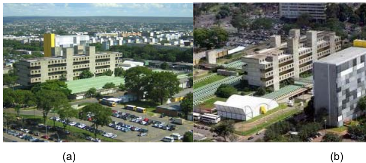
Figura 1: O conjunto arquitetônico do Hospital Sarah Asa Sul implantado em área adensada: a) Vista do bloco principal; b) Complexo hospitalar.
