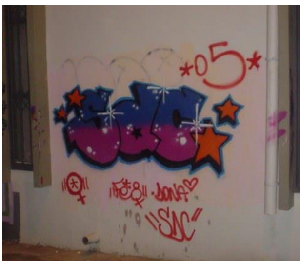
Figura 5. Senhoritas Destruidoras Crew
