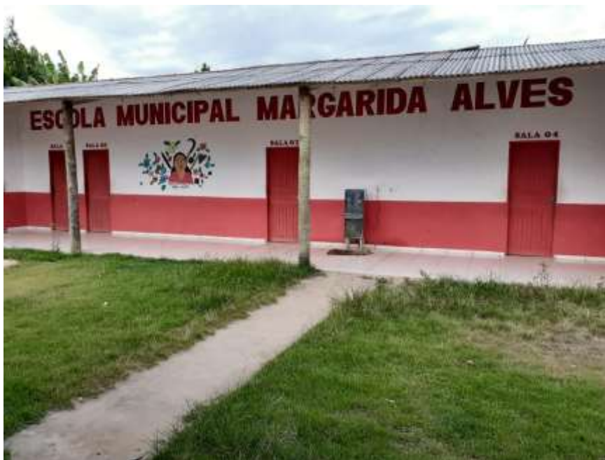
Imagem 111 - Escola municipal Margarida Alves onde o grupo dormiu durante a “Caravana Burlesca 2020 - Circulação por áreas da Reforma Agrária no Extremo Sul da Bahia” no assentamento Margarida Alves do MST/BA, Itabela - BA, 2020. Fonte: Arquivo do grupo.
