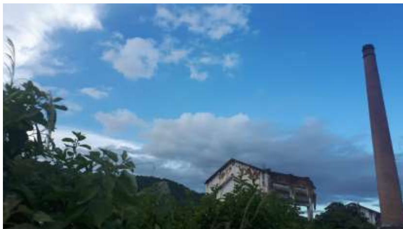
Imagem 75 - Foto da ruína da Usina Tanques, atual Assentamento Nova Margarida, Alagoa Grande - PB, 2019. Fonte: Arquivo do grupo.
