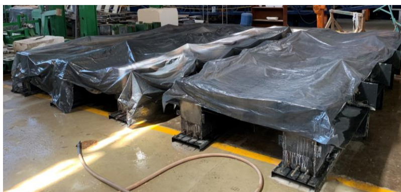
Figura 3.12: Cura das vigas do programa experimental.
