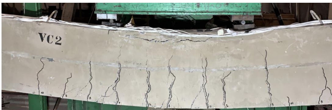
Figura 4.2: Vista frontal do trecho central da viga VC2 após o ensaio.
