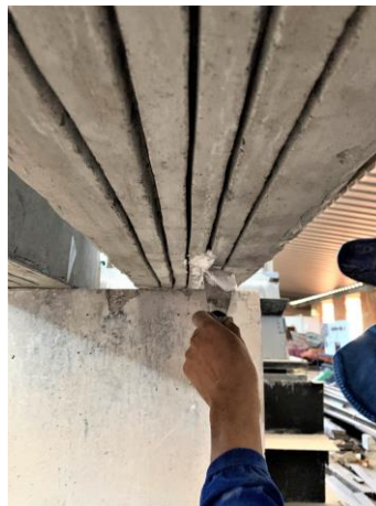
(e) Preenchimento da ranhura com a resina
