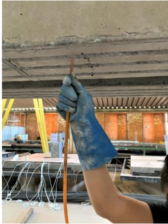
(a) Limpeza do substrato
