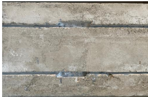
Figura 3.23: Abertura da ranhura para o posicionamento do extensômetro do laminado de PRFC.
