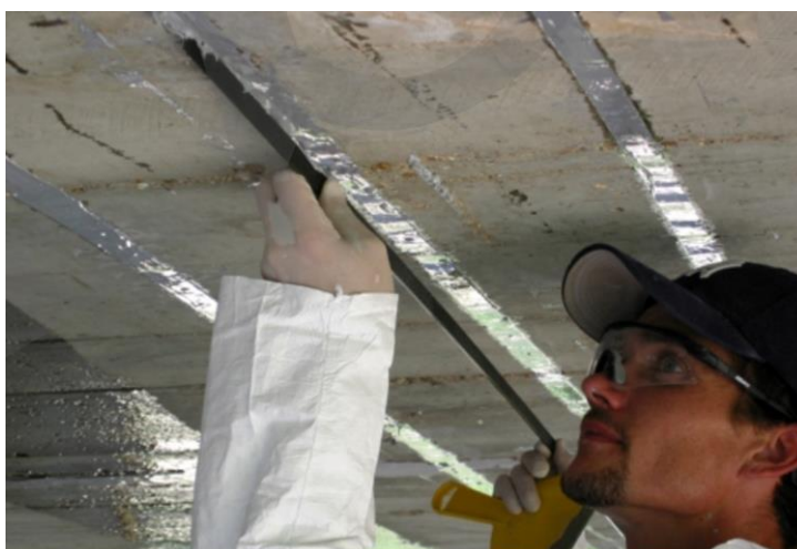
Figura 1.3: Laje reforçada com técnica NSM [ fib Bulletin 90 (2019)].
