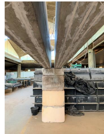
(f) Inserção da fibra, acabamento e aspecto final do reforço
