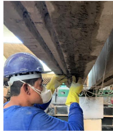
(f) Preenchimento da ranhura e acabamento final.
