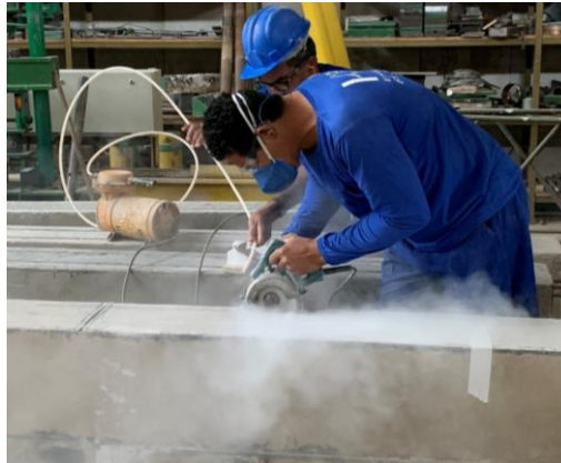
Figura 3.22: Abertura das ranhuras nas vigas.
