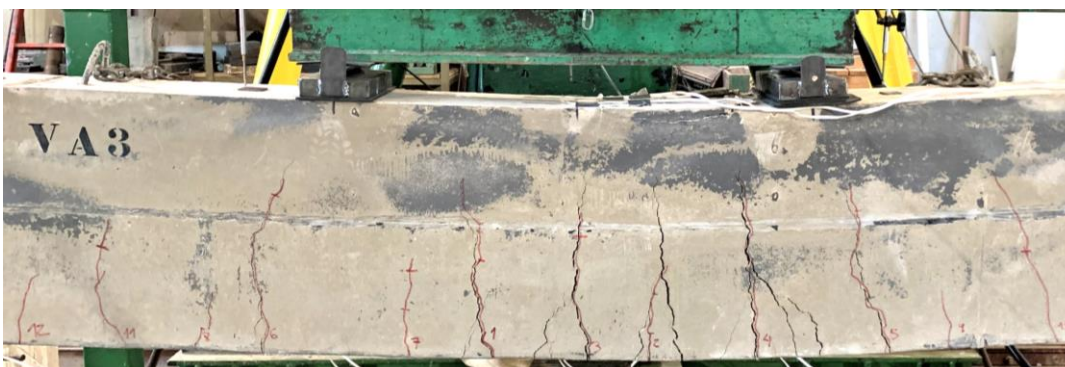
Figura 4.7: Vista frontal do trecho central da viga VA3 após o ensaio.
