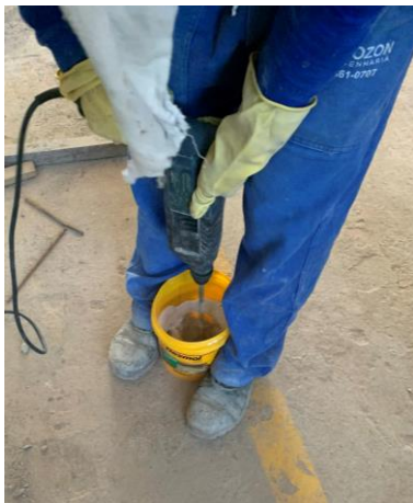
(d) Mistura dos dois componentes da resina
