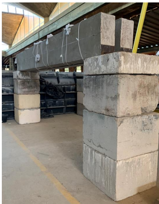
Figura 3.28: Vigas posicionadas para a execução do reforço.
