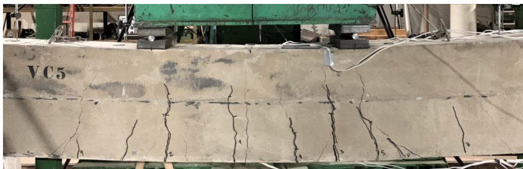
Figura 4.5: Vista frontal do trecho central da viga VC5 após o ensaio.
