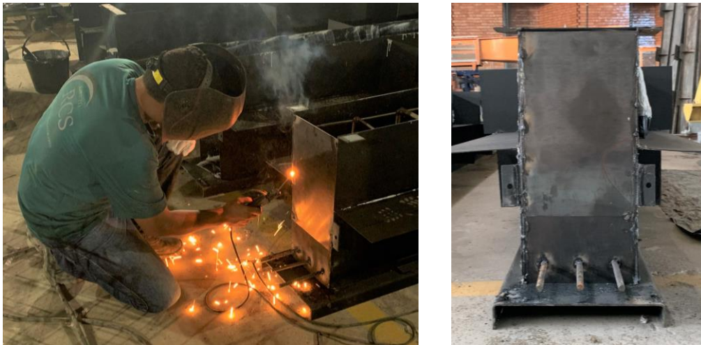
(a) (b) Figura 3.10: Soldagem da chapa de ancoragem mecânica.
