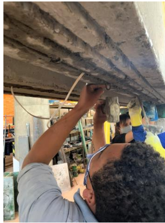
(e) Posicionamento dos ganchos nos furos executados previamente.
