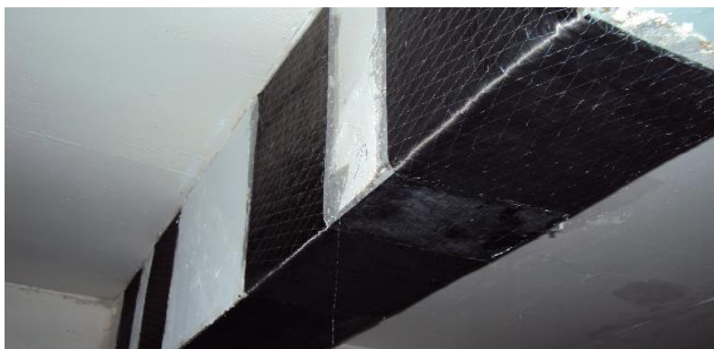
Figura 1.2: Viga reforçada à flexão com técnica EBR [ http://techniques.com.br/ ].
