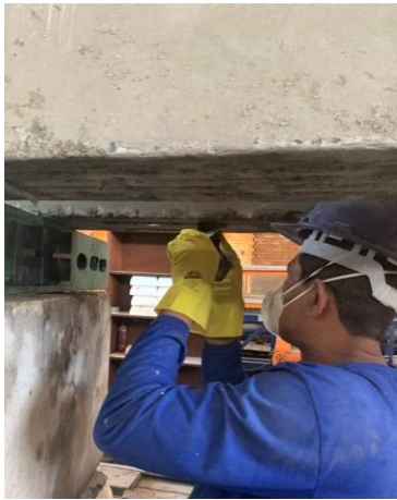
(d) Preenchimento da metade da ranhura com a argamassa polimérica.
