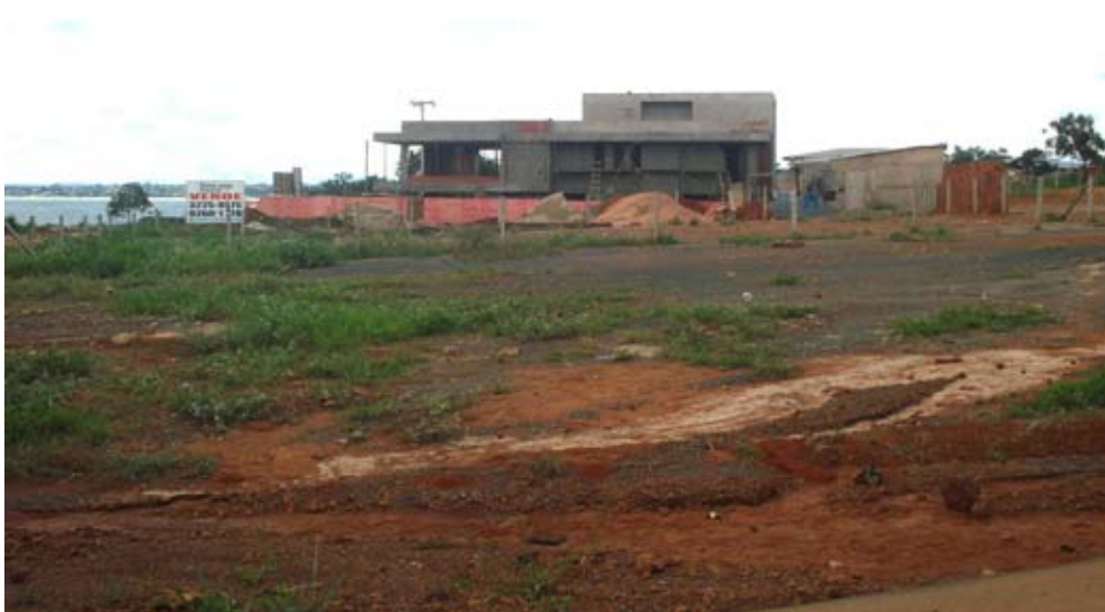
Figura 52: Área do Centro de Lazer Beira Lago em atual implantação Fonte: Foto do autor (2007).
