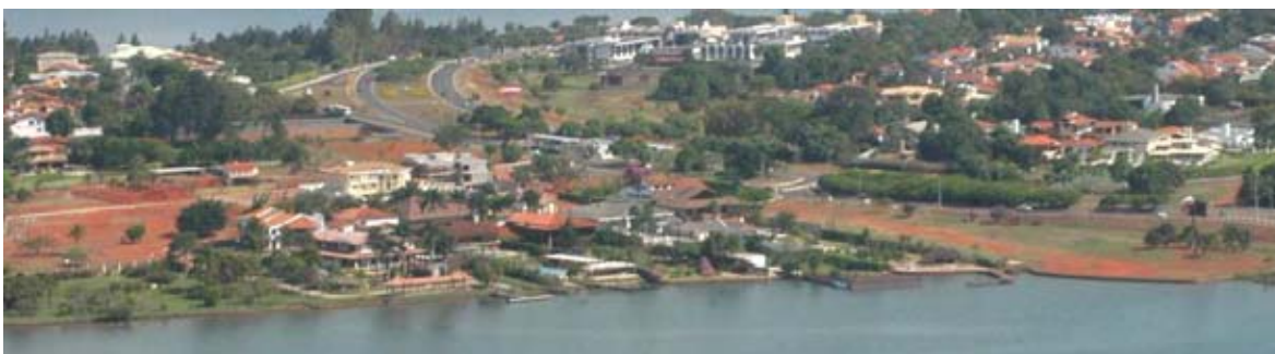
Figura 101: Área com erosão e solo exposto no começo da QL 12 Fonte: Seduma (2005).
