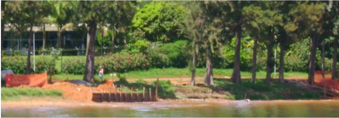
Figura 102: Escavações e manchas de solo exposto no Parque Ecológico Península Sul Fonte: Foto do autor (2007).
