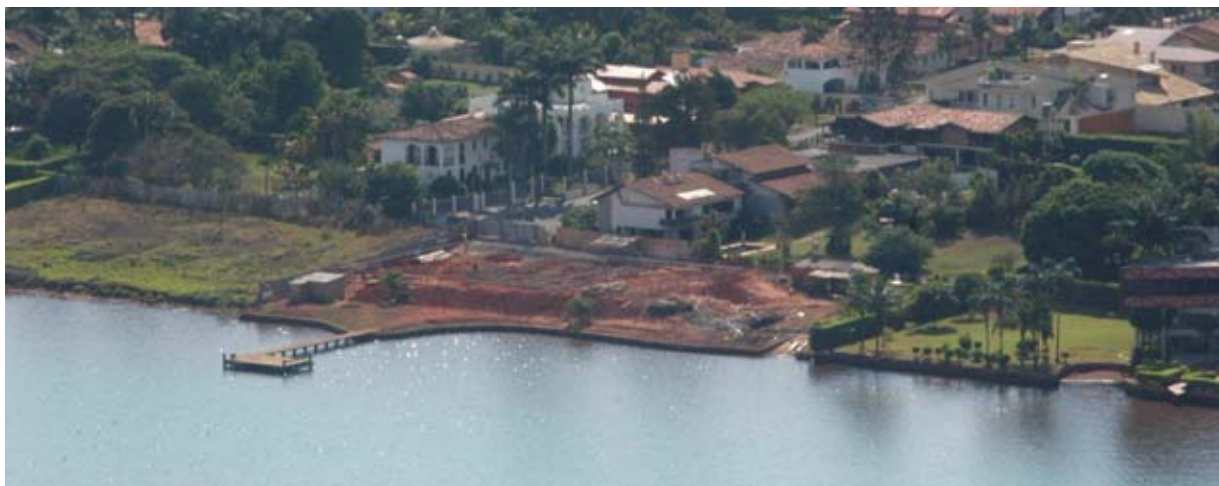
Figura 105: Escavações e solo revirado em obras na faixa da APP do Lago Paranoá, na QL 14 Fonte: Seduma (2005).
