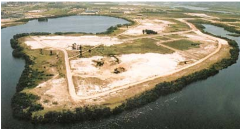
Figura 9: Vista da degradação na aérea do parque antes da sua implantação Fonte: Chacel (2001, p. 50).
