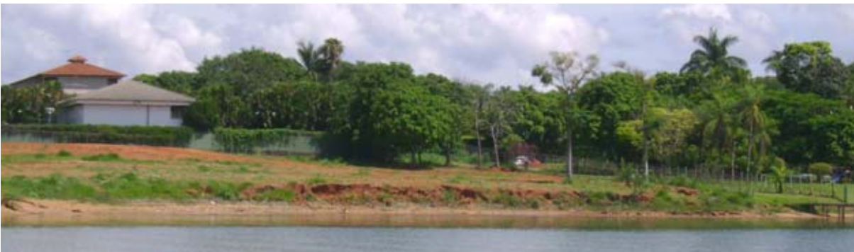
Figura 103: Lote desocupado e com presença de processos erosivos Fonte: Foto do autor (2007).
