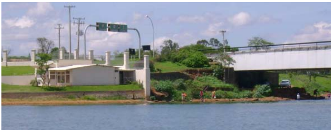
Figura 126: Exemplo de barreiras no Pontão do Lago Sul Fonte: Foto do autor (2007).
