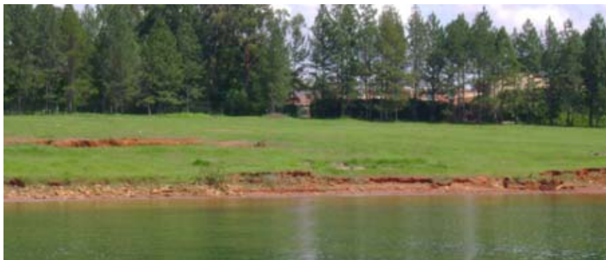
Figura 104: Alguns processos erosivos no Parque do Anfiteatro Natural do Lago Sul Fonte: Foto do autor (2007).
