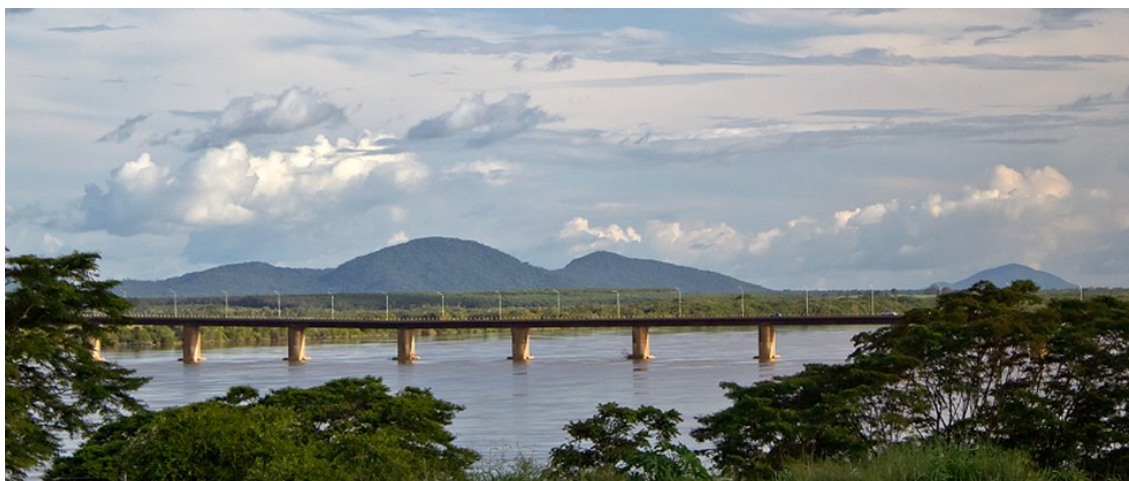
Figura 32 - Ponte dos Macuxi com vista da Serra Grande (Boa Vista).
