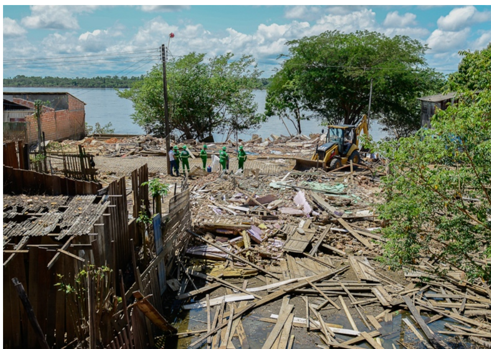
Figura 27 - Demolição das casas no Beiral (2017) – Boa Vista-RR
